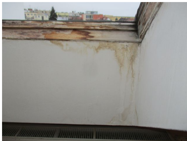
foto/2/ Pohled na vlhkostní mapy v místě střešního okna patro mezonetového bytu č. 33
