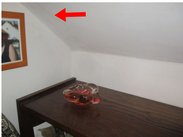
foto/3/ Pohled na vlhkostní mapy v místě napojení svislé konstrukce na šikmou část sádkartonových podhledů – patro mezonetového bytu č. 32
