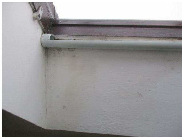
foto/4/ Pohled na vlhkostní mapy v místě střešního okna patro mezonetového bytu č. 32
