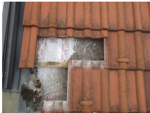
foto/6/ Pohled na zapravenou sondu S1 v místě šikmé střechy
