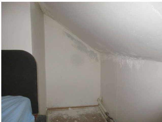
foto/1/ Pohled na vlhkostní mapy v místě napojení svislé konstrukce na šikmou část sádkartonových podhledů – patro mezonetového bytu č. 33
