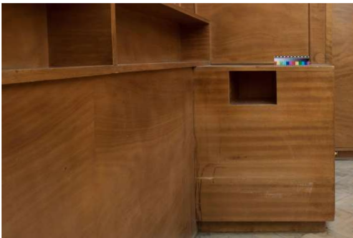
Pravá skříňka – průhled od poličky, poškození povrchové úpravy a skvrny po stékající kapalině
