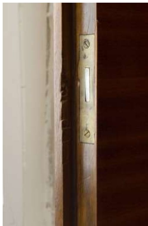
Detail zámku a poškození hrany vzniklé páčením
