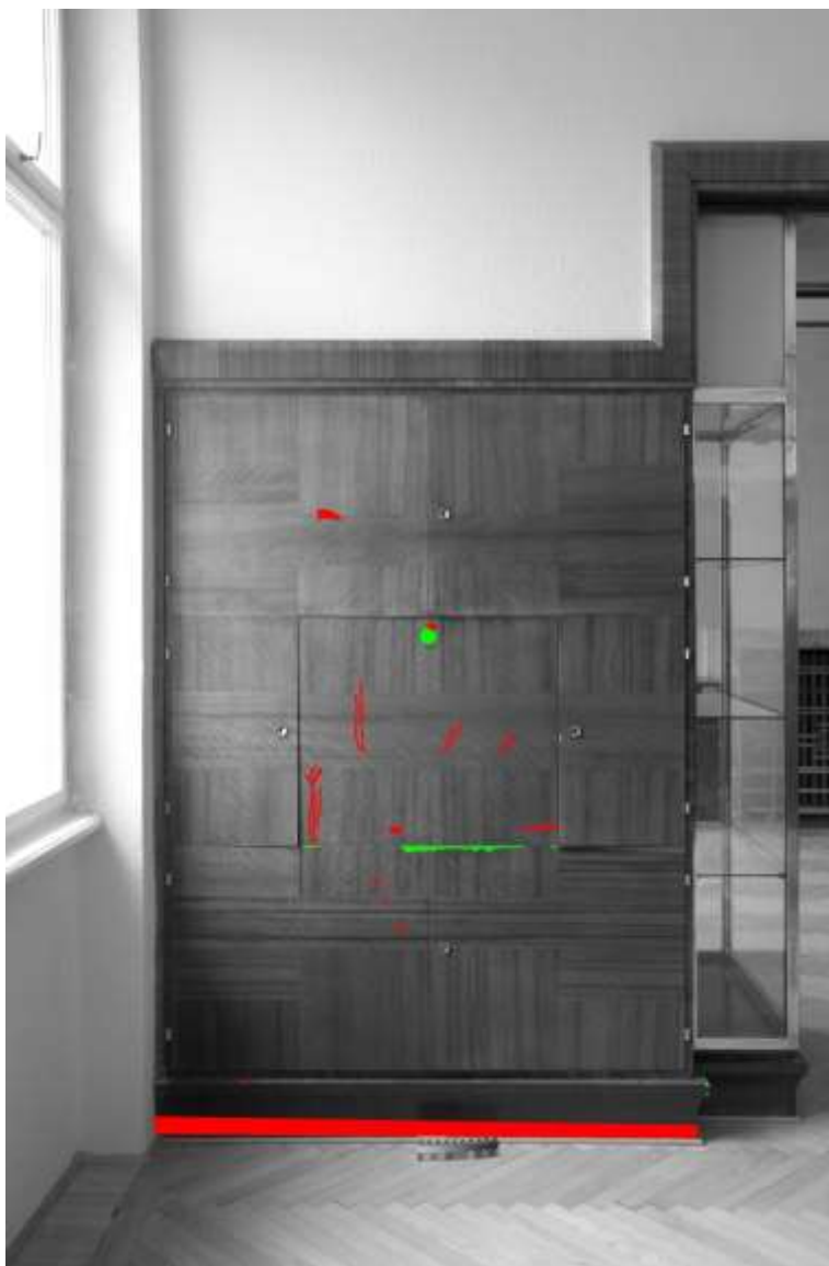
Mapa poškození, dělicí stěna levá, zavřená
