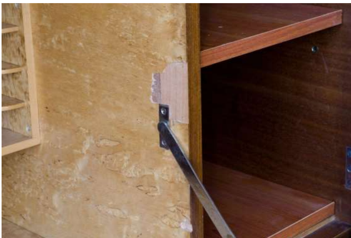
Detail chybějící dýhy
