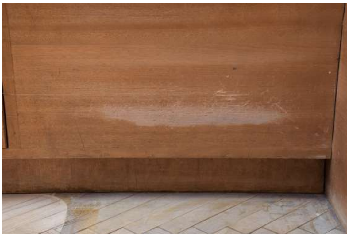
Detail poškození povrchové úpravy v levé části sedacího koutu
