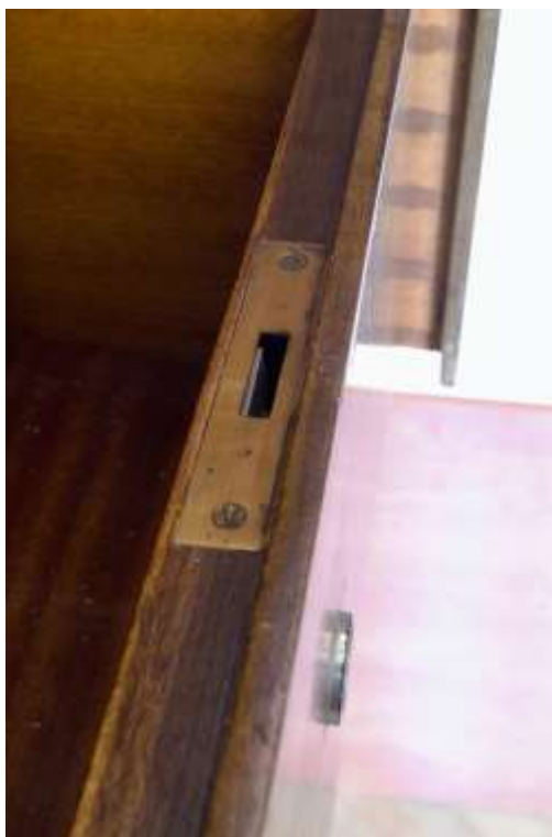
Detail poškozeného zámku
