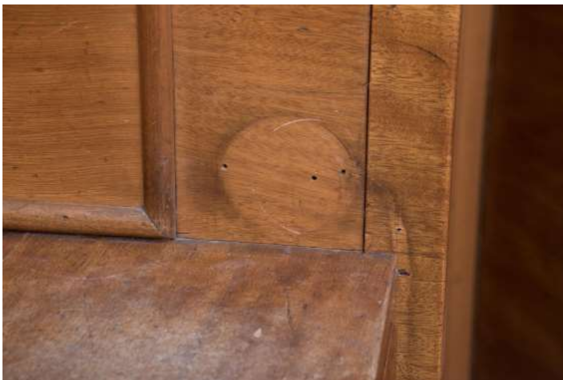
Detail poškození stěny u pravé skříňky
