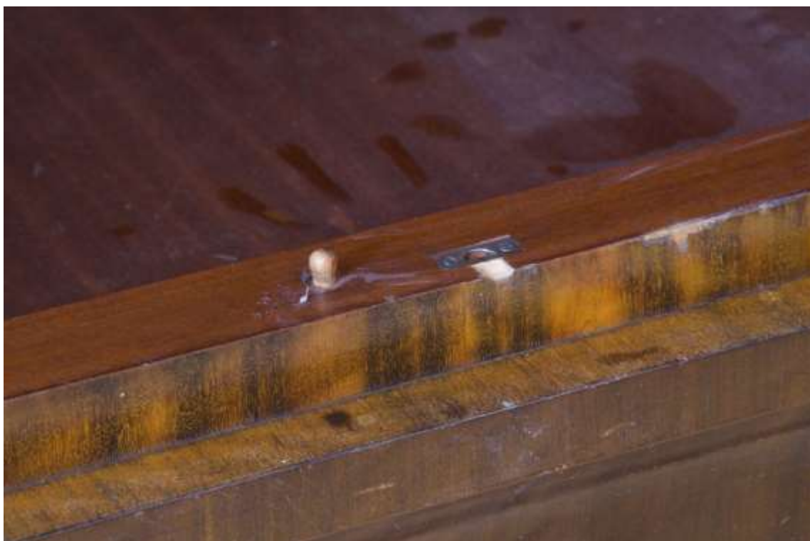
Detail spodního zapadacího plechu a vymezovacího kolíku
