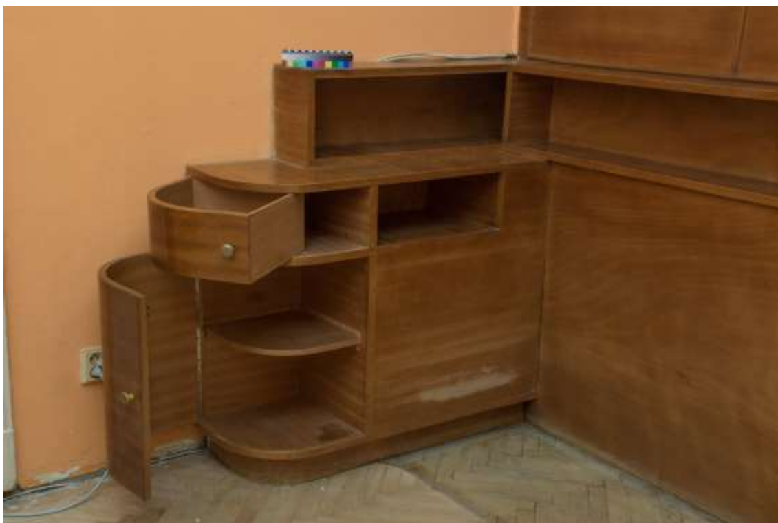
Levá skříňka – vyklápěcí zásuvka, oblouková dvířka, poškození povrchové úpravy
