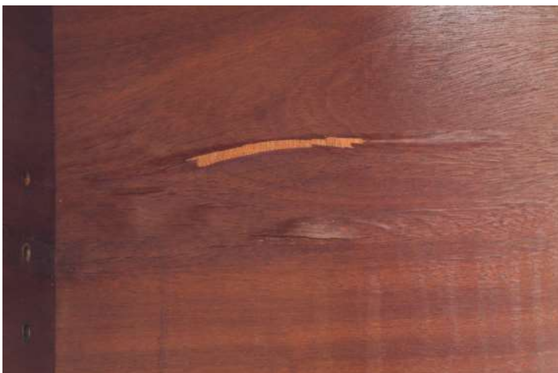
Detail chybějící dýhy
