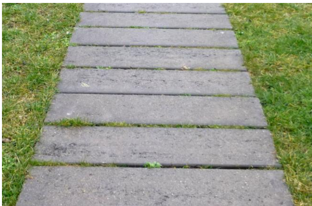
Pěšina z nášlapných betonových pásků se zatravněnou spárou (šířka 1 m)
