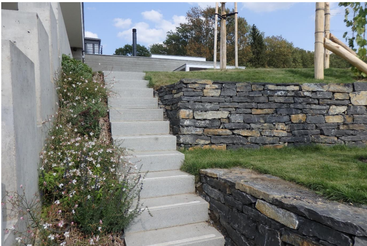
Prefabrikované betonové stupně v kombinaci s kamennou zídou.
