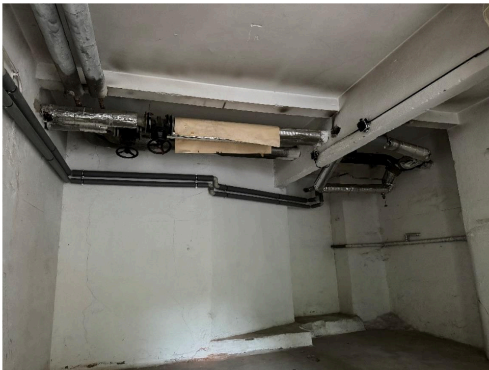
Obrázek: místnost č.11 - garáž
