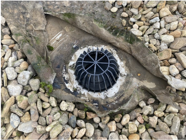
foto/36/ Pohled na střešní vtok opatřený ochranným košem v blízkosti instalační šachty
