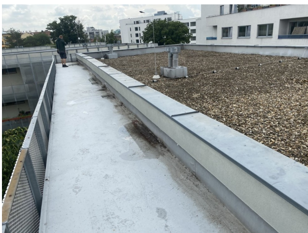
foto/5/ Pohled na předmětnou plochu střechu pavlače
