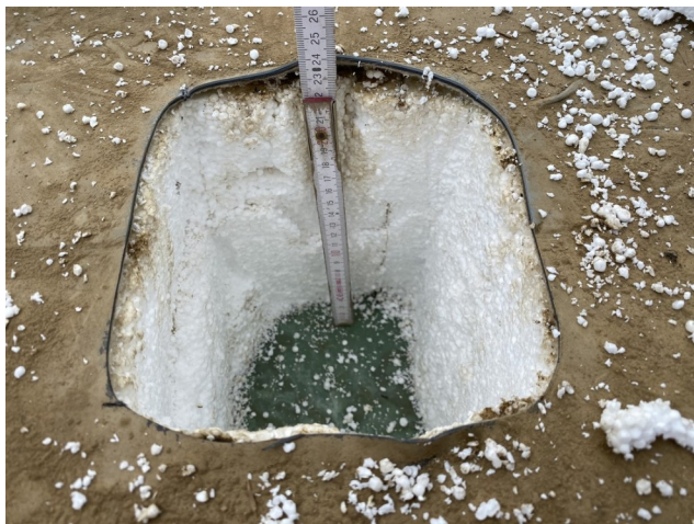
foto/15/ Pohled na provedenou sondu S3
