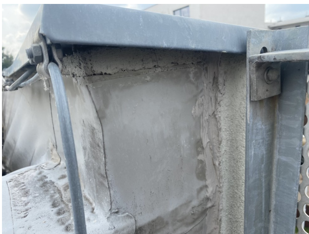
foto/24/ Pohled na opracování atiky
