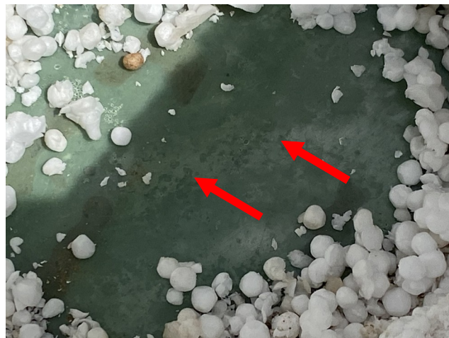
foto/16/ Pohled na viditelnou vlhkost pod PE fólií v místě sondy S3
