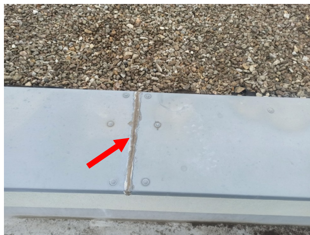
foto/25/ Pohled na spojení jednotlivých segmentů oplechování pomocí tmele
