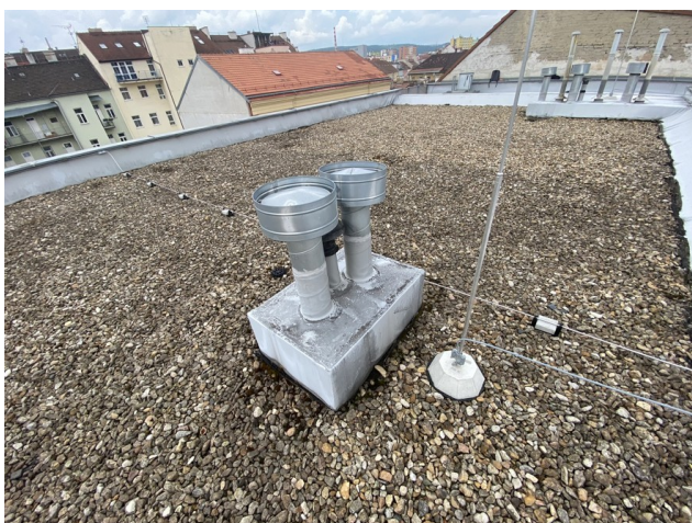
foto/7/ Pohled na předmětnou plochu střechu
