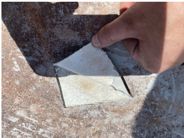
foto/9/ Pohled na provedenou sondu S1
