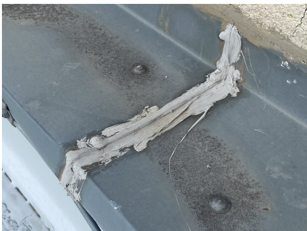
foto/26/ Pohled na spojení jednotlivých segmentů oplechování pomocí tmele
