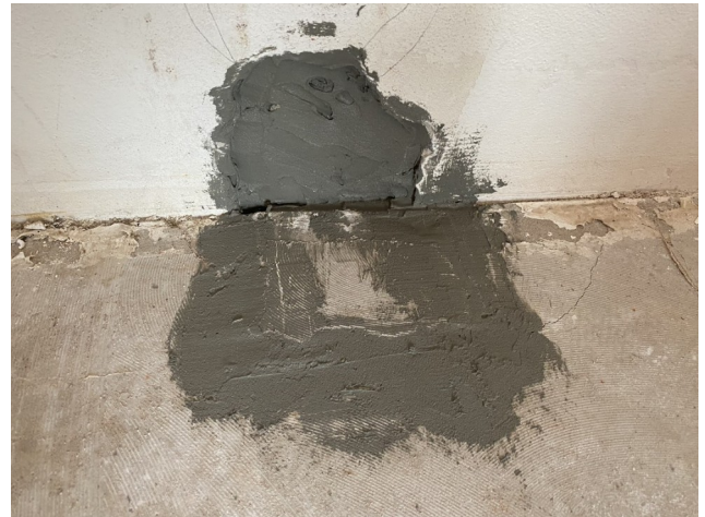
foto/59/ Pohled na zapravenou sondu P2
