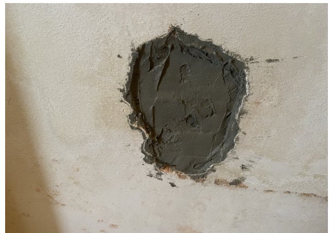
foto/51/ Pohled na zapravenou sondu B1
