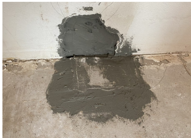
foto/53/ Pohled na zapravenou sondu B2
