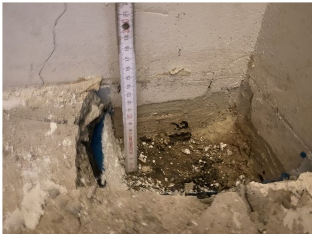
foto/54/ Pohled na provedenou sondu P1
