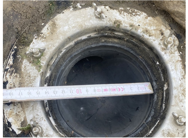
foto/37/ Pohled na průměr střešního vtoku (průměr cca 125 mm)
