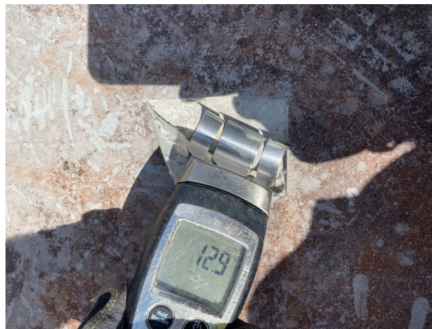
foto/10/ Pohled na změřenou hmotnostní vlhkost betonu v místě sondy S1 (naměřeno 12,9%)
