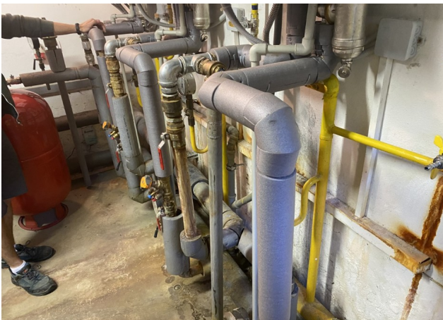
foto/48/ Pohled na stěnu instalační šachtu v místě kotelny
