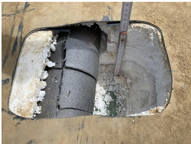
foto/12/ Pohled na provedenou sondu S2
