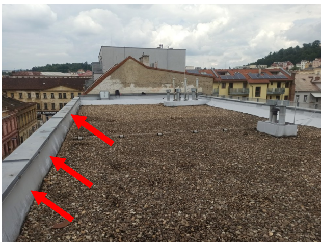
foto/32/ Pohled na napnutí fólie u okraje atiky
