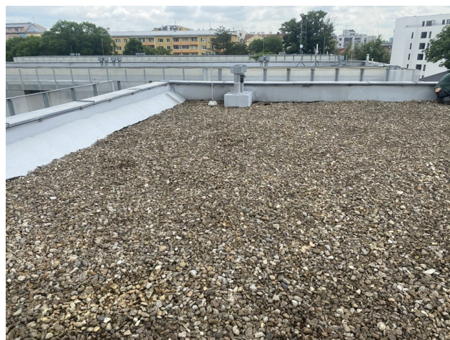
foto/8/ Pohled na předmětnou plochu střechu
