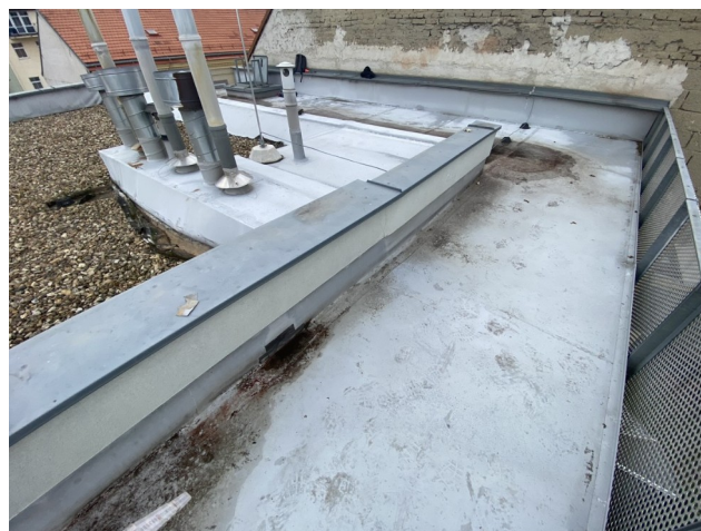
foto/6/ Pohled na předmětnou plochu střechu pavlače
