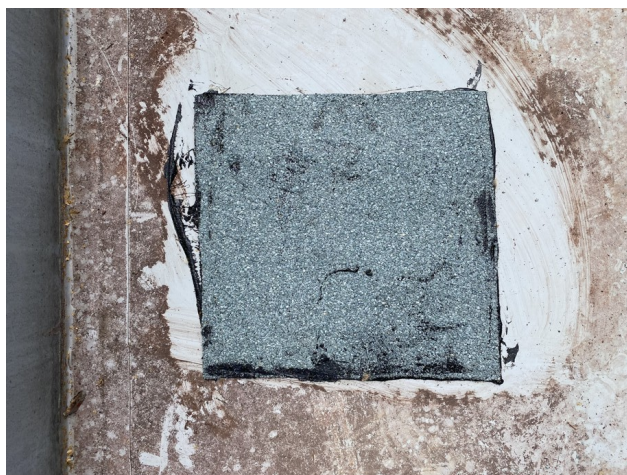
foto/11/ Pohled na provizorně zapravenou sondu S1
