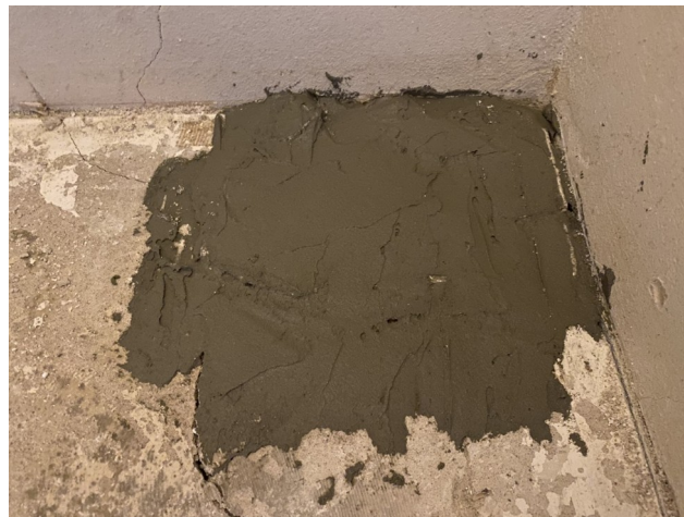
foto/55/ Pohled na zapravenou sondu P1
