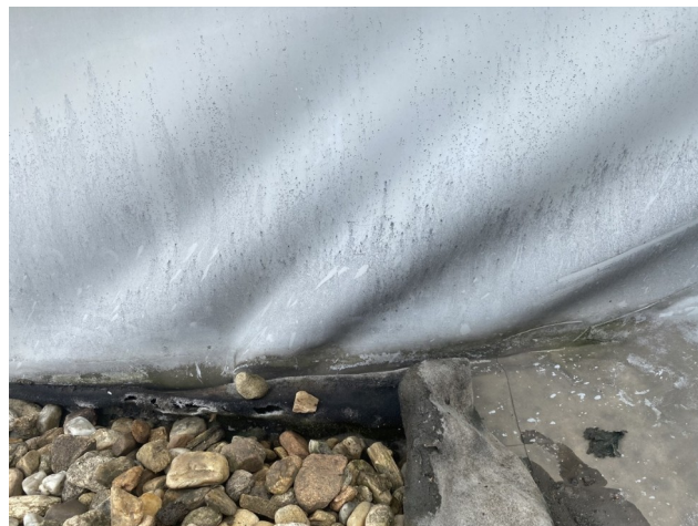
foto/33/ Pohled na napnutí fólie u okraje atiky
