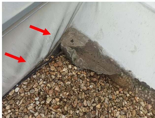
foto/31/ Pohled na napnutí fólie v koutě atiky
