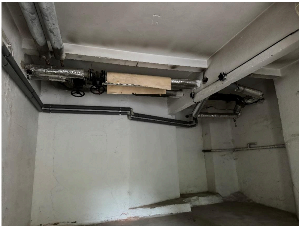
Obrázek: místnost č.11 - garáž
