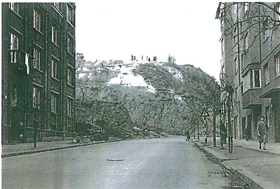
Obr. 2. Pohled z ulice Úvoz směrem k jejímu dnešnímu křížení s ulicí Grohovou. Skalní svah před stavebními úpravami. Vlevo bytový dům čp. 422 pro zaměstnance Báňské a hutní společnosti od arch. Karla Lehmanna z roku 1923, rohový dům čp. 130 dosud nestojí (foto Archiv města Brna).
