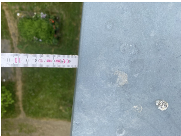
foto/22/ Pohled na vzdálenost hrany okapnice od vnějšího líce fasády (~30 mm)
