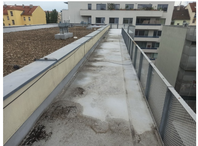
foto/2/ Pohled na předmětnou plochu střechu pavlače
