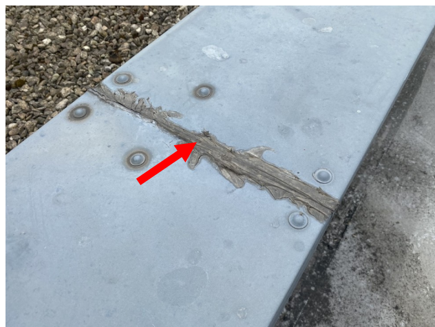
foto/23/ Pohled na spojení jednotlivých segmentů oplechování pomocí tmele
