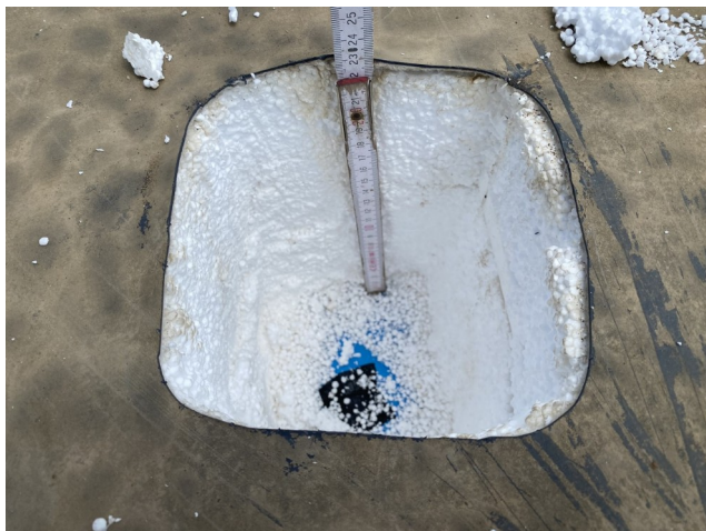
foto/5/ Pohled na provedenou sondu S1
