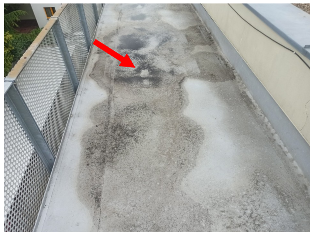
foto/13/ Pohled kaluže a nečistoty v ploše střechy pavlače
