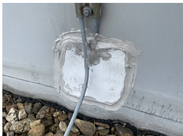
foto/19/ Pohled na opravování prostupu vodiče bleskosvodu
