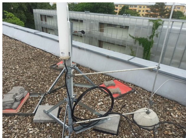
foto/15/ Pohled na stabilizaci konstrukce antény pomocí betonových dlaždic
