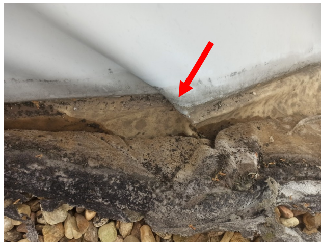
foto/31/ Pohled na odtržený kotevní prvek včetně koutové lišty
