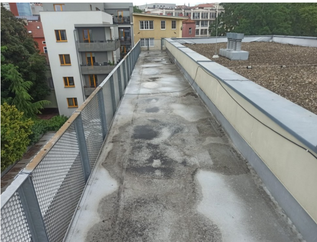
foto/1/ Pohled na předmětnou plochu střechu pavlače
