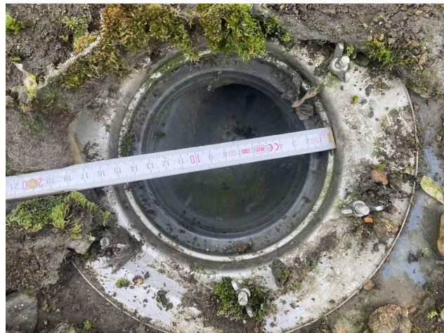
foto/35/ Pohled na průměr střešního vtoku (průměr cca 125 mm)
