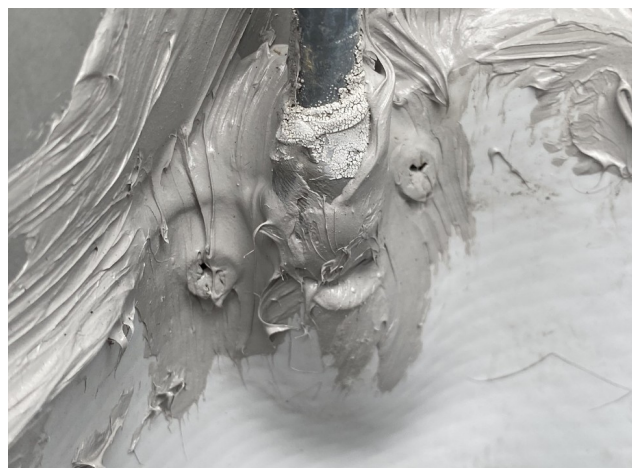
foto/21/ Detailní pohled na opravování prostupu vodiče bleskosvodu
