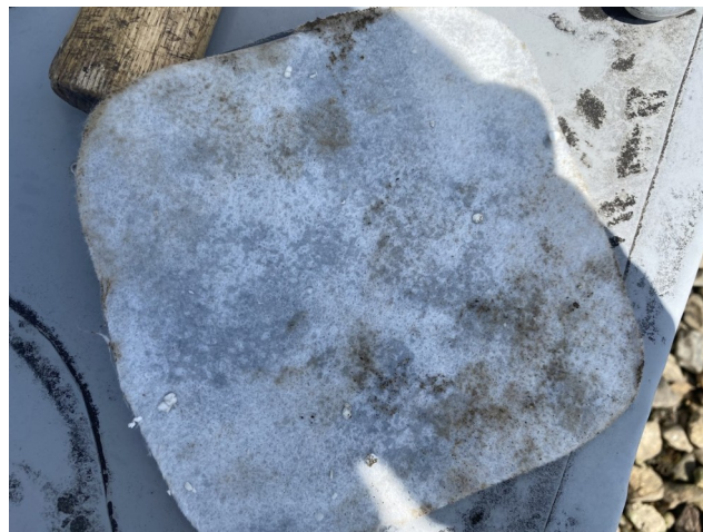
foto/6/ Pohled na mokrou nakaširovanou geotextilii fólie v místě sondy S1
