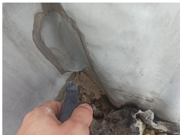
foto/27/ Pohled na netěsnost v místě záplaty v rohu atiky
