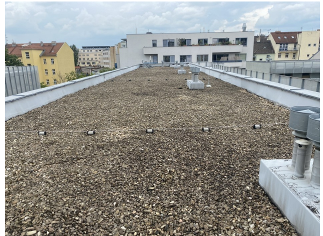
foto/4/ Pohled na předmětnou plochu střechu
