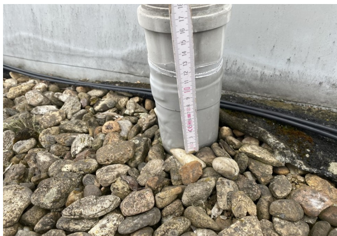
foto/14/ Pohled na opravování kruhového detailu (vytažení HI cca 120 mm)
