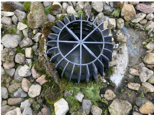
foto/34/ Pohled na střešní vtok opatřený ochranným košem v blízkosti instalační šachty
