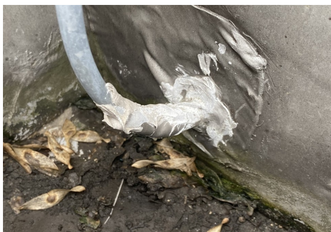
foto/18/ Pohled na opravování prostupu vodiče bleskosvodu
