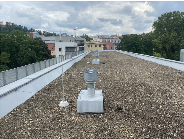
foto/3/ Pohled na předmětnou plochu střechu
