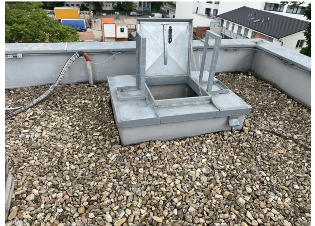
foto/16/ Pohled na střešní výlez
