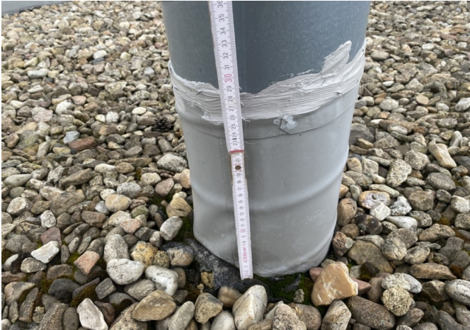
foto/13/ Pohled na opravování kruhového detailu (vytažení HI cca 260 mm)
