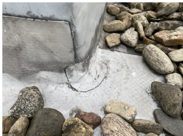
foto/20/ Pohled na opravování čtvercového prostupu
