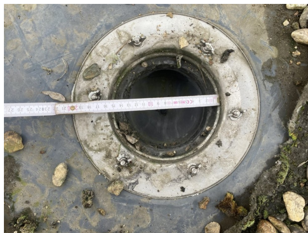
foto/30/ Pohled na průměr střešního vtoku (průměr cca 125 mm)
