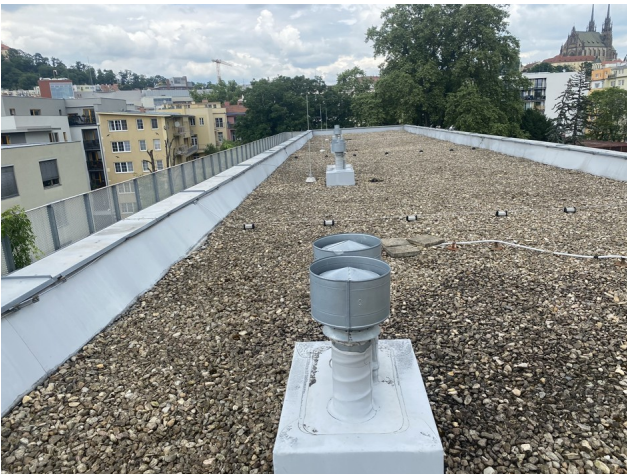
foto/3/ Pohled na předmětnou plochou střechu
