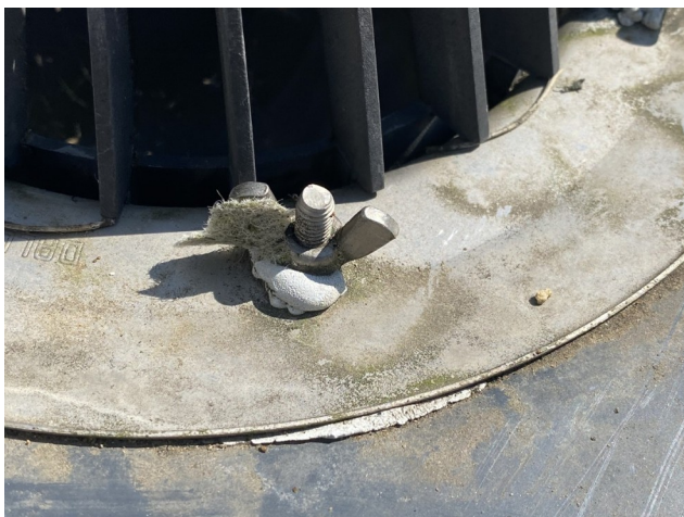
foto/31/ Pohled na utěsnění křídlových matic střešního vtoku pomocí tmele
