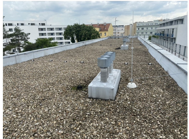
foto/4/ Pohled na předmětnou plochou střechu
