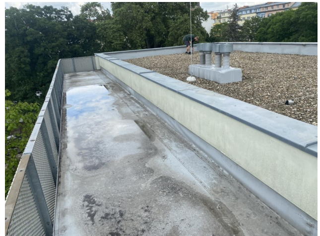
foto/2/ Pohled na předmětnou plochou střechu pavlače
