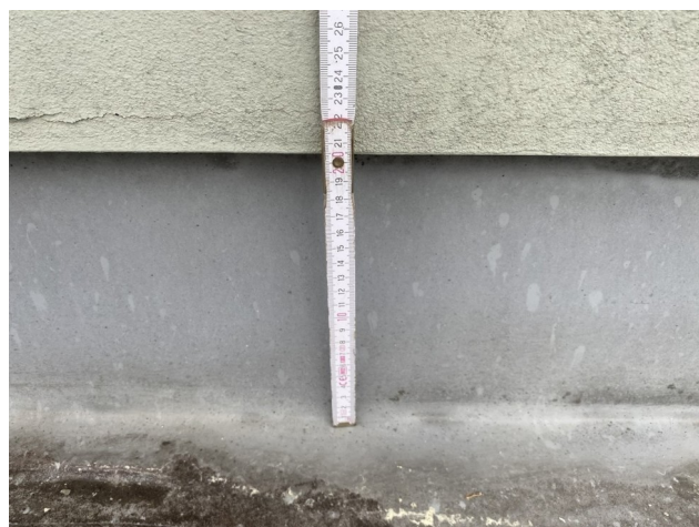
foto/26/ Pohled na výšku vytažení hydroizolační fólie na stěnu atiky (cca 200 mm)
