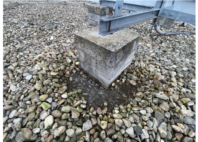
foto/14/ Pohled na stabilizaci konstrukce antény pomocí betonových podstavců, vypodložených přířezem asfaltového pásu
