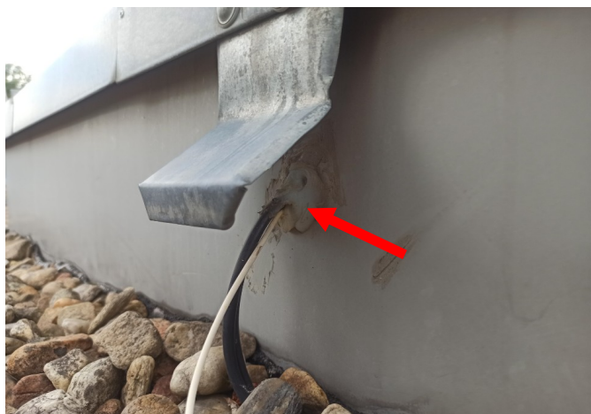
foto/19/ Pohled na opravování kruhového prostupu elektroinstalace a provizorní oplechování
