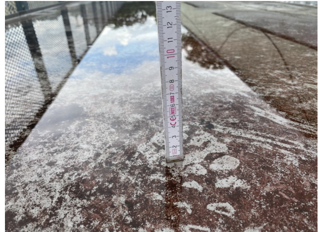
foto/11/ Pohled na výšku hladiny stojící vody v místě střechy pavlače (cca 10 mm)
