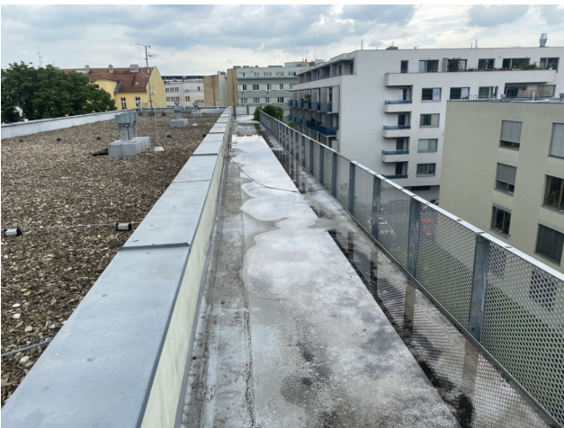
foto/1/ Pohled na předmětnou plochou střechu pavlače
