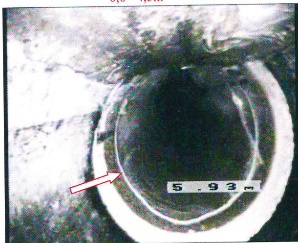
FOTO 004: 0,0m - překážka odtoku, pevná, dno cca 10 - 40% profilu v úseku 0,0 - 4,5m
