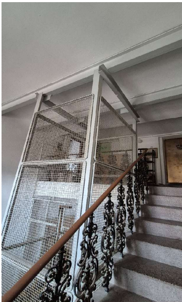
Hlava šachty výtahu bez stanice v 5.NP
