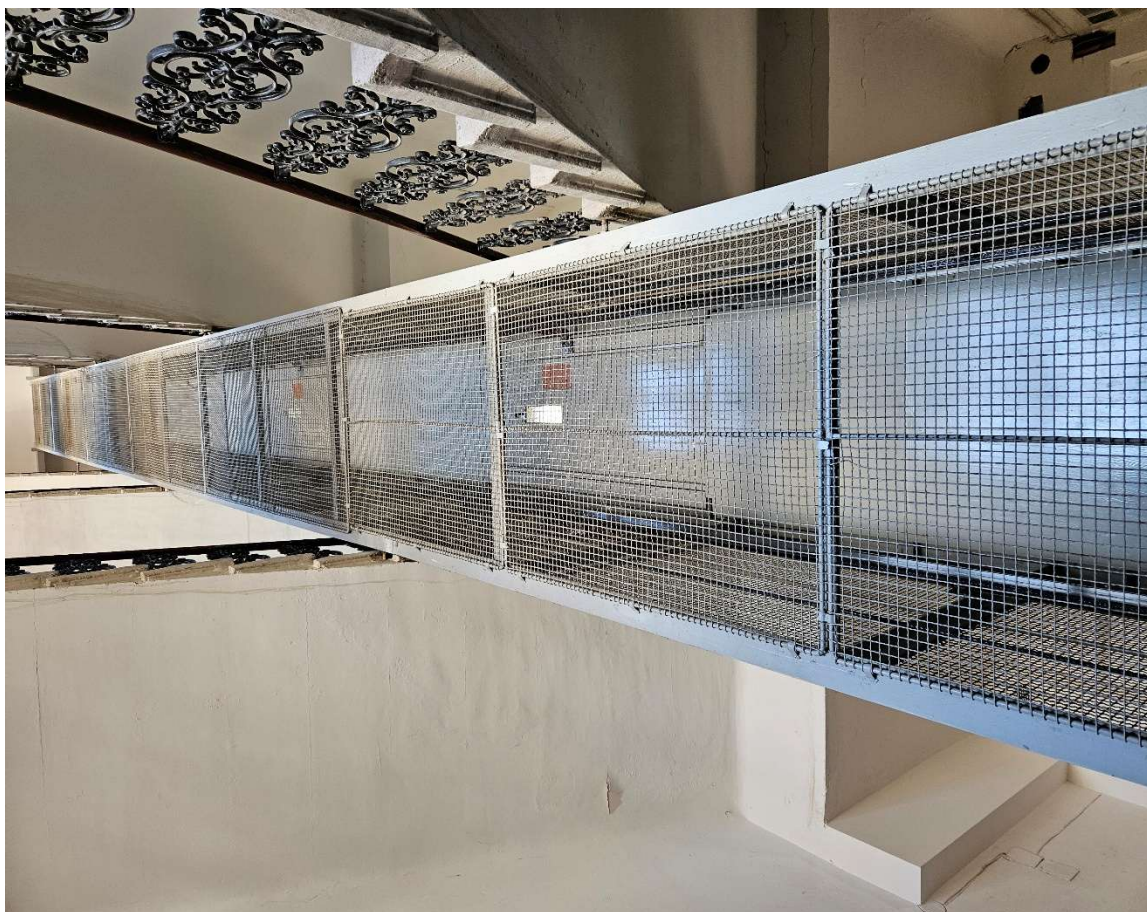
Pohled do zrcadla schodiště z 1.NP
