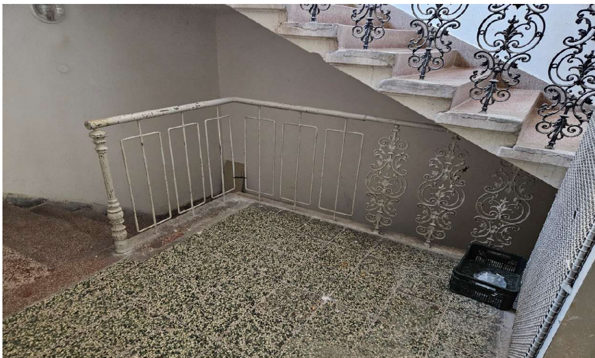
Prostor za výtahem – 1.NP a schodiště do suterénu v 1.PP
