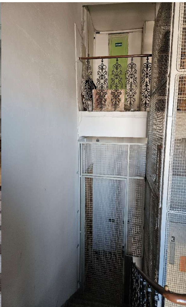
Poslední stanice výtahu ve 4 NP a podesta v 5 NP
