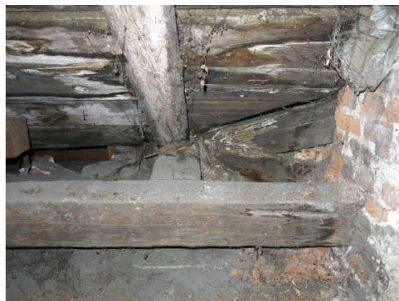
Obr.č.9 a 10 – stékající voda na vazný trám, poškozené části střechy a krovu
