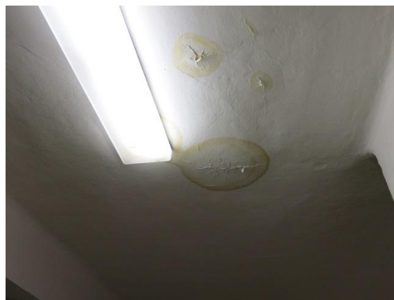
Obr.č.5 a 6 – Zatékání ze střechy projevující se na stropě/podhledu v patře
