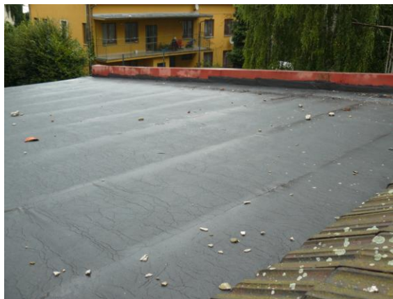
Obr.č.1 - Nevhodné (nefunkční) napojení šikmé a ploché střechy
