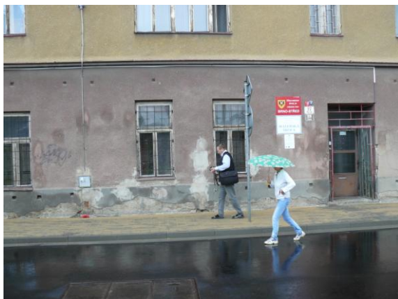
Obr.č.19 a 20 – poškozený sokl a část fasády objektu, nedostatečně vyřešené napojení chodníku na objekt, zastaralá a poškozená okna
