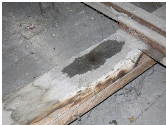
Obr.č.9 a 10 – stékající voda na vazný trám, poškozené části střechy a krovu
