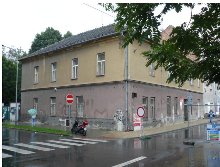
Obr.č.22 – Celkový pohled na budovu z ulice
