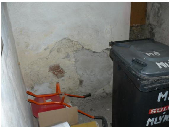
Obr.č.13 a 14 – poškozená omítka v přízemí objektu – zapuštěná část objektu pod terénem (technické zázemí objektu)
