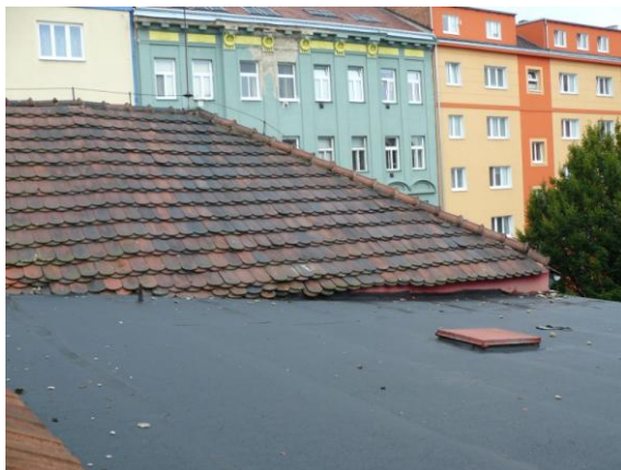
Obr.č.1 - Nevhodné (nefunkční) napojení šikmé a ploché střechy
