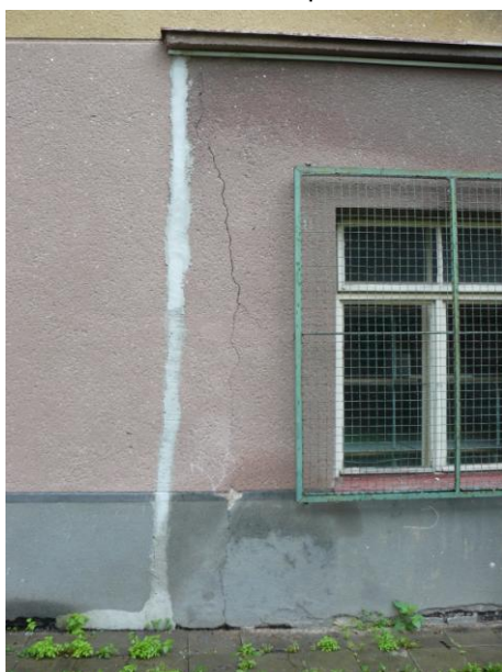
Obr.č.17 – dvorní fasáda: svislá trhlina patrná v místě napojení novějšího dvorního přístavku
