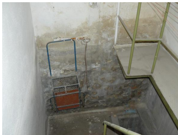
Obr.č.13 a 14 – poškozená omítka v přízemí objektu – zapuštěná část objektu pod terénem (technické zázemí objektu)
