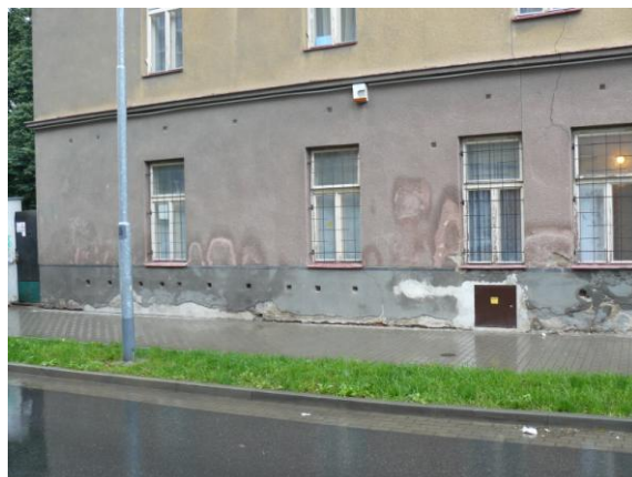
Obr.č.19 a 20 – poškozený sokl a část fasády objektu, nedostatečně vyřešené napojení chodníku na objekt, zastaralá a poškozená okna
