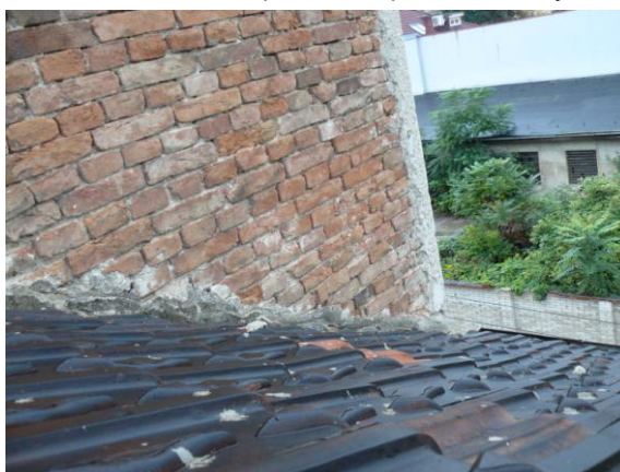
Obr.č.3 – Chybějící oplechování štítové stěny souseda
