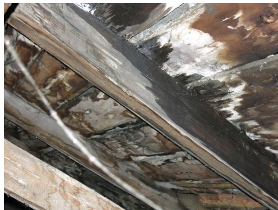
Obr.č.9 a 10 – stékající voda na vazný trám, poškozené části střechy a krovu
