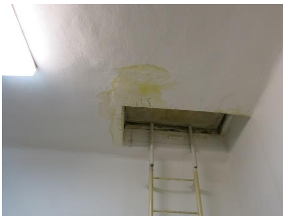
Obr.č.5 a 6 – Zatékání ze střechy projevující se na stropě/podhledu v patře
