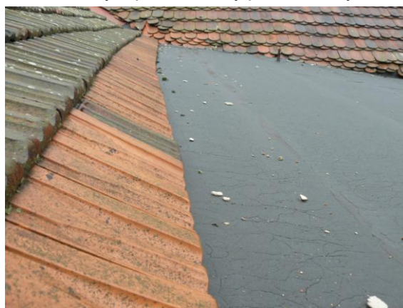
Obr.č.3 – Chybějící oplechování štítové stěny souseda
