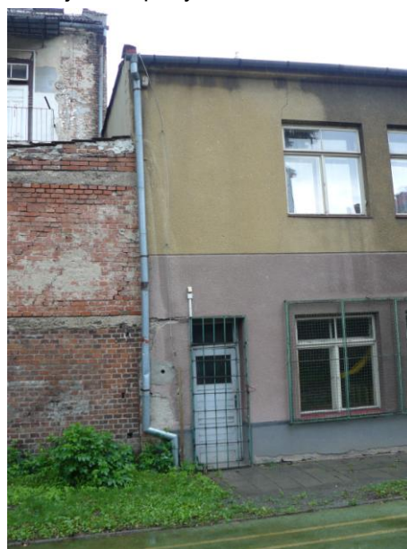
Obr.č.17 – dvorní fasáda: svislá trhlina patrná v místě napojení novějšího dvorního přístavku
