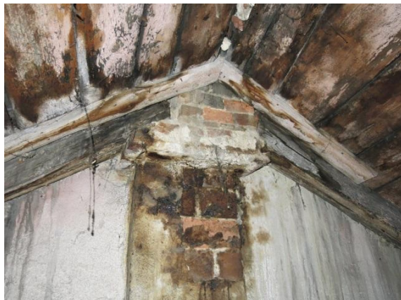
Obr.č.7 a 8 – Štitová stěna u hřebene a zbytečná snaha o dílčí opravy v předchozích letech
