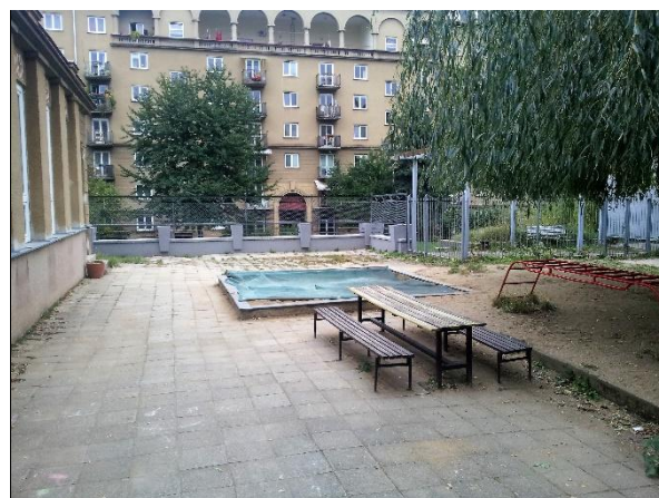
Obr. 4 – Pohled na zadní část podél budovy
