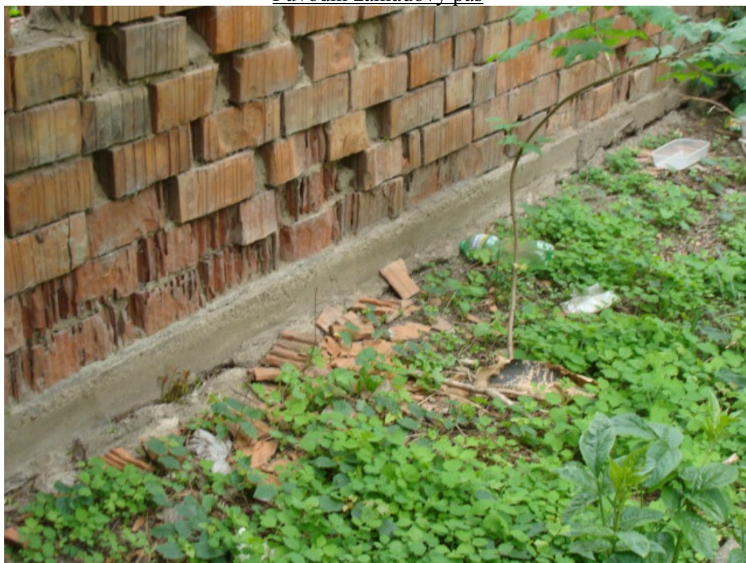
Původní základový pas
