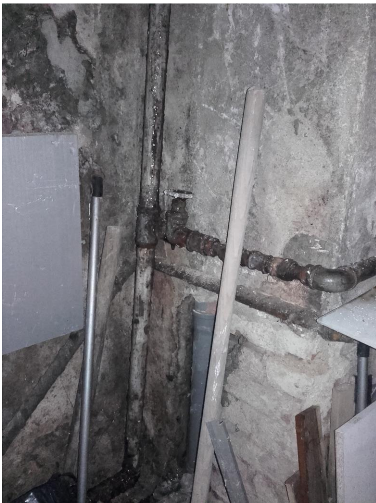
Obr. č. 1 Stávající vodovodní stoupačka
