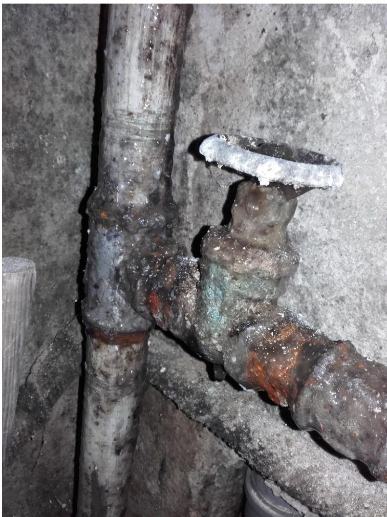
Obr. č. 2 Nefunkční uzávěr vody na odbočce
