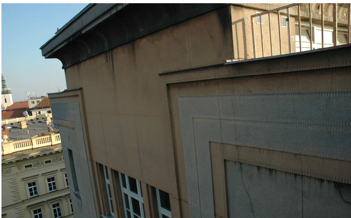
Kombinace dvou odstínů teracových omítek na nárožním bloku objektu.
