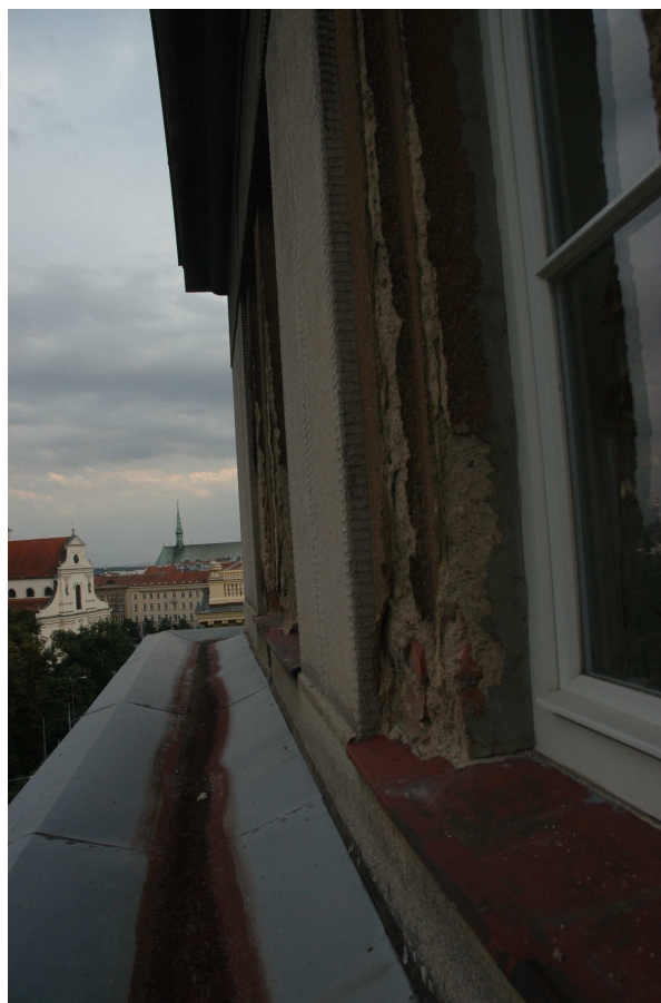
Detail dvouvrstvých vápenno cementových omítek s vápenným okrovým nátěrem na ploše fasády nad předstupující korunní římsou.
