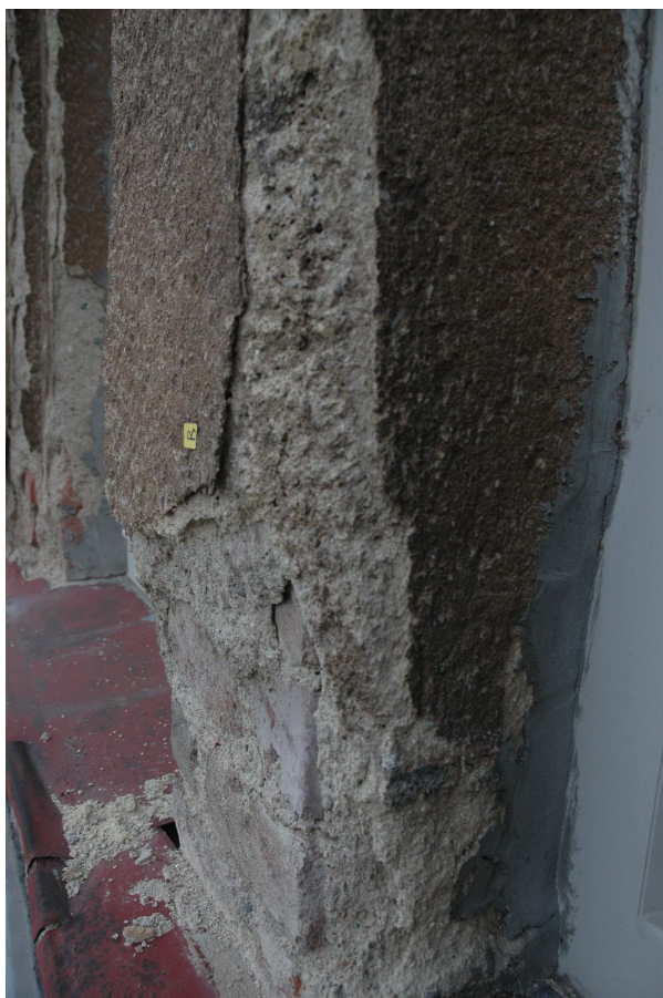
Detail dvouvrstvých vápenno cementových omítek s vápenným okrovým nátěrem na ploše fasády nad předstupující korunní římsou.
