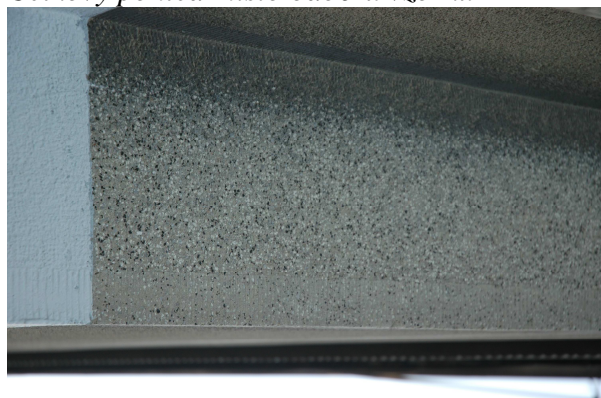
Detail povrchu teraca, na hranách dekorativní fasetování. Při levém okraji fotografií patrný šedý sekundární nátěr.
