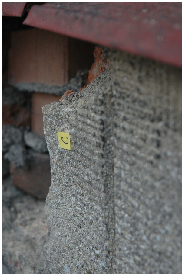
Celkový pohled a detail místa odběru vzorku C. Plocha parapetu pod oknem VI. NP, hlavní průčelí
