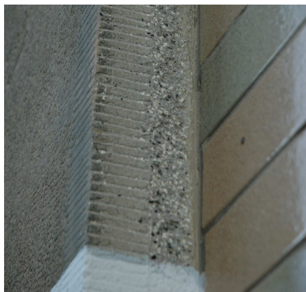
Detail teracových omítek parterové části
