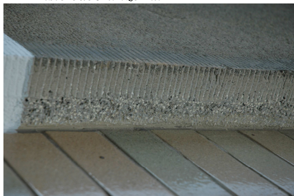
Detail povrchu teraca, na hranách dekorativní fasetování. Při levém okraji fotografií patrný šedý sekundární nátěr.
