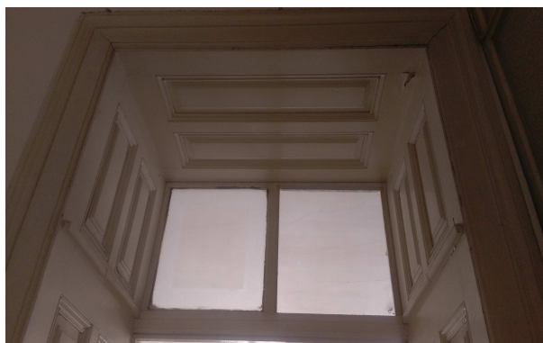
Obr. č.63 – Obloužková zárubeň nadsvětlíku
