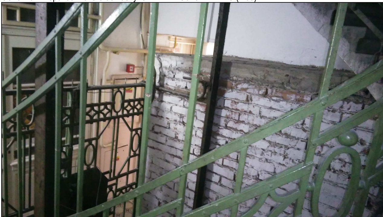
Obr č. 42 – Obezdnění stávající koupelny pod schodišťovým ramenem
