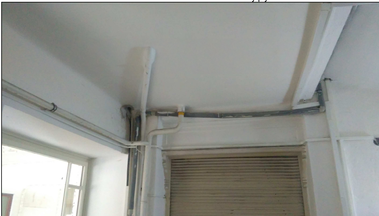
Obr. č. 15 – Odpady od bytu č.5 – vedeny pod stropem schodišťové podesty – budou odstraněny
