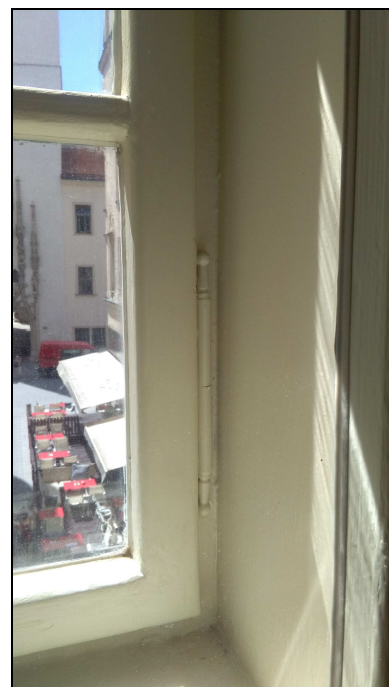
Obr č. 28 – Původní okenní panty
