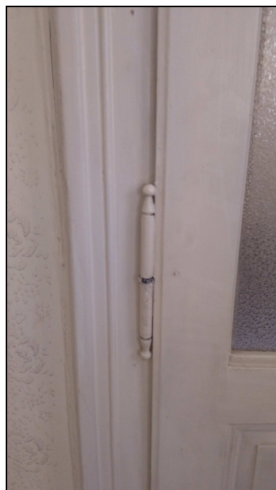
Obr. č. 31 – Původní dveřní panty
