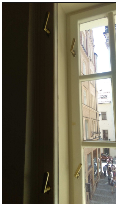
Obr č. 27 – Původní okenní kličky
