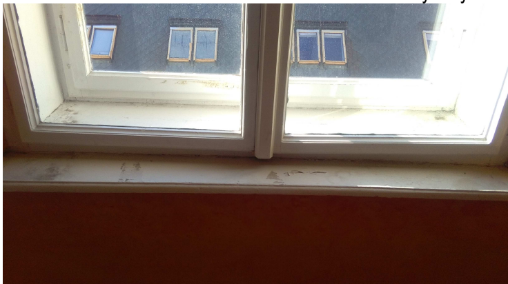
Obr.č.39 – Okno – původní dřevěný parapet
