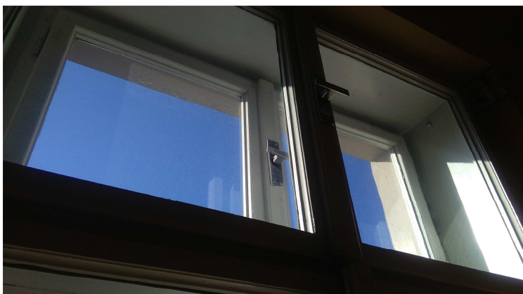
Obr.č.38 – Okno – nadsvětlik – obě křídla nové klíčky – vyměnit
