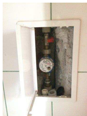
Obr č. 19 – vodoměr
