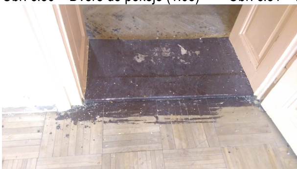
Obr. č.33 – Nevhodným nátěrem poškozený práh
