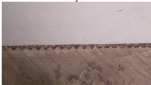
Obr č. 16 – Podlaha chodby – chybějící lišty
