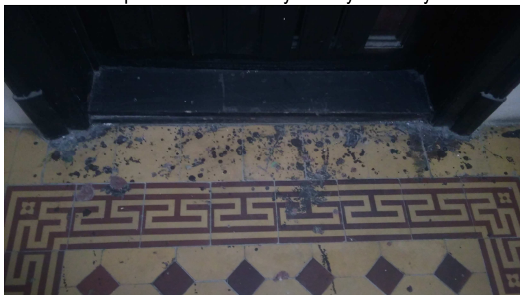
Obr č. 9 – Vstupní dveře – ze strany chodby - poškozená dlažba
