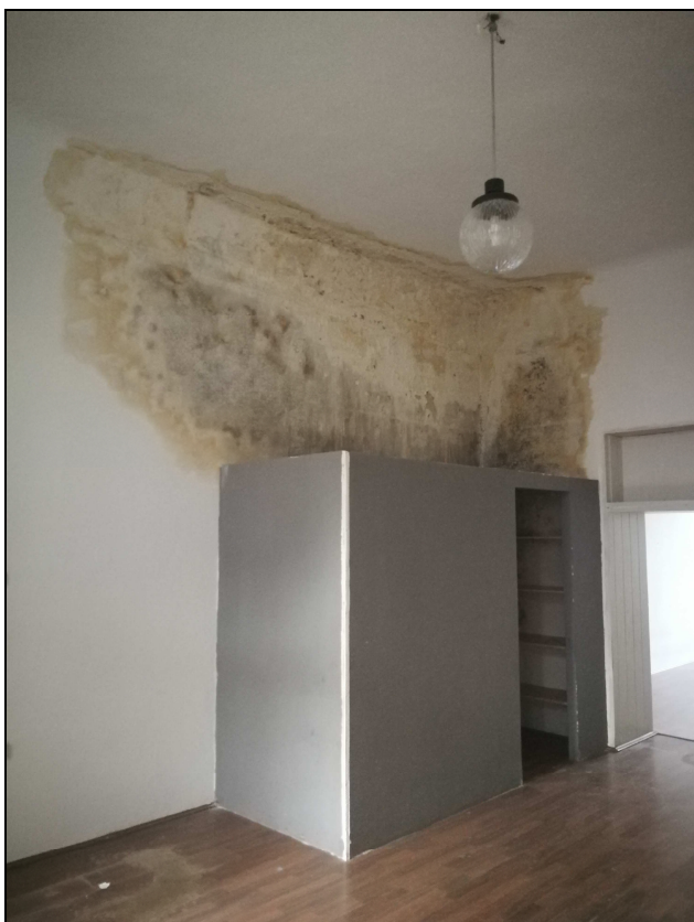
Obr č. 15 – Masívní zatečení (1.12)
