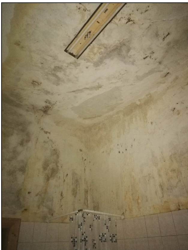
Obr č. 30 – Masívní zatečení - koupelna (1.07)
