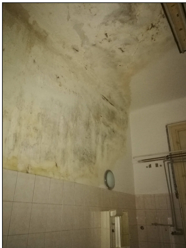
Obr č. 31 – Masívní zatečení - koupelna (1.07)
