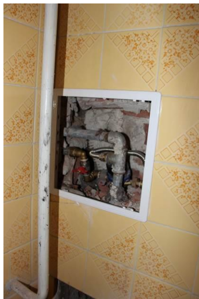
Vodoměr umístěný v koupelně
