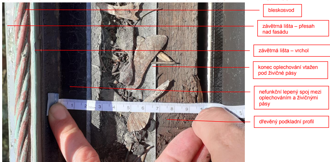
POHLED SHORA NA DŘEVĚNÝ PODKLADNÍ PROFIL OPLECHOVÁNÍ - PO ODKRYTÍ ŽIVIČ. PÁSU
