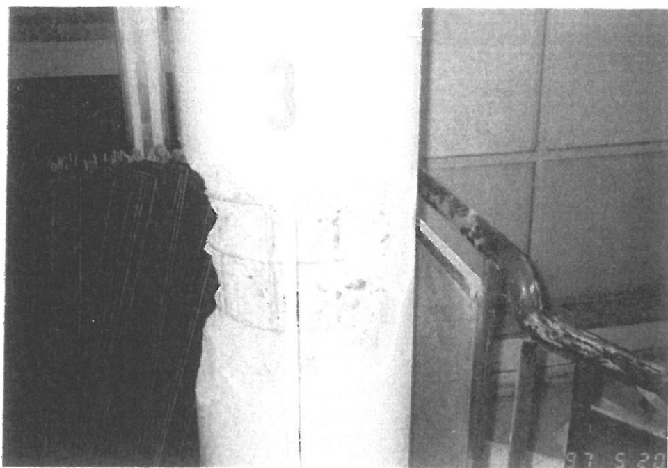
Foto 3 : 2. NP – žeb. kruhový sloup při vstupu má excentricky umístěnou hlavní výztuž ( ROXOR prof. 16 , šroubovice o Cc 8 ).
