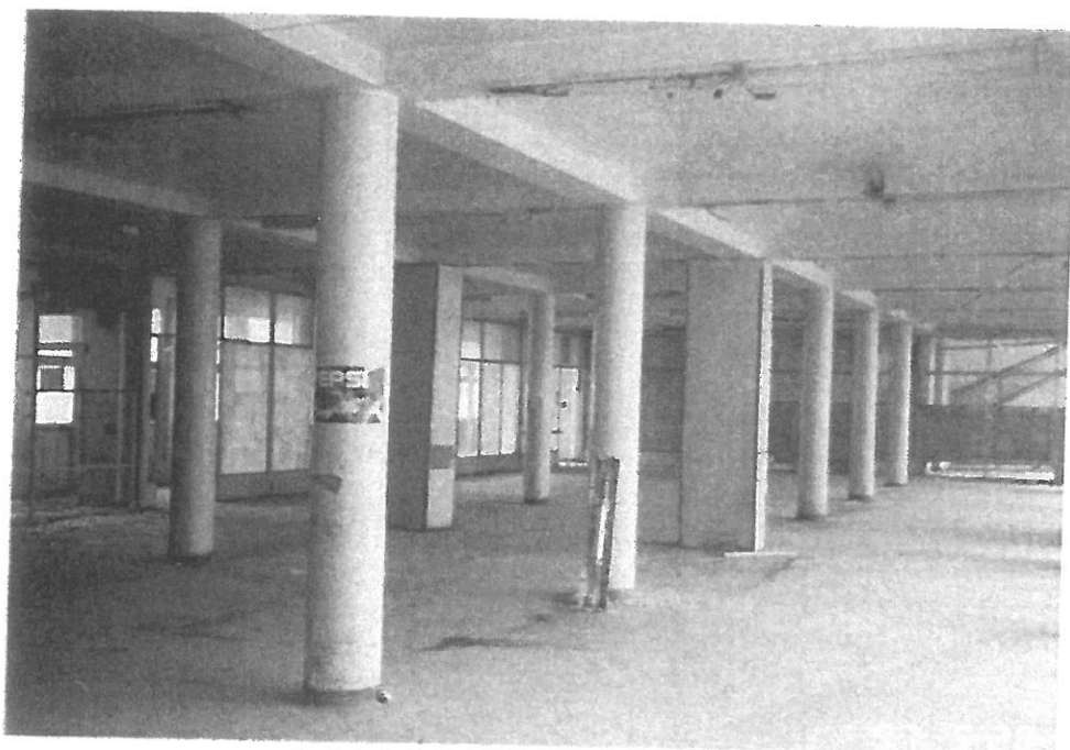
Foto 5 : 2.NP - pohled na žebet. monolitický skelet s kruhovými sloupy a deskami s náběhy ( pohled od Zelného trhu ).
