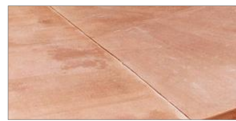
5 probarvený beton - galerijní cesta
