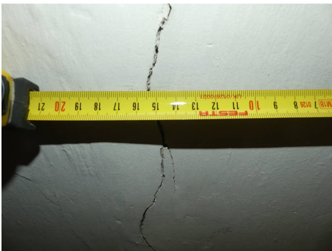
Foto 1.6 – Pohled na trhlinu stěny, která se nachází v místnosti č. 3.003.07 ve 3NP, šířka trhliny dosahuje až 3,0 mm.
