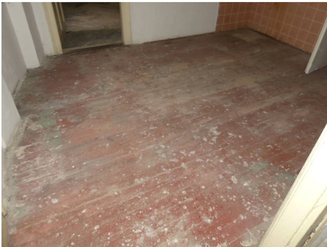
Foto 1.19 – Pohled na prošlapanou nášlapnou vrstvu podlahy.
