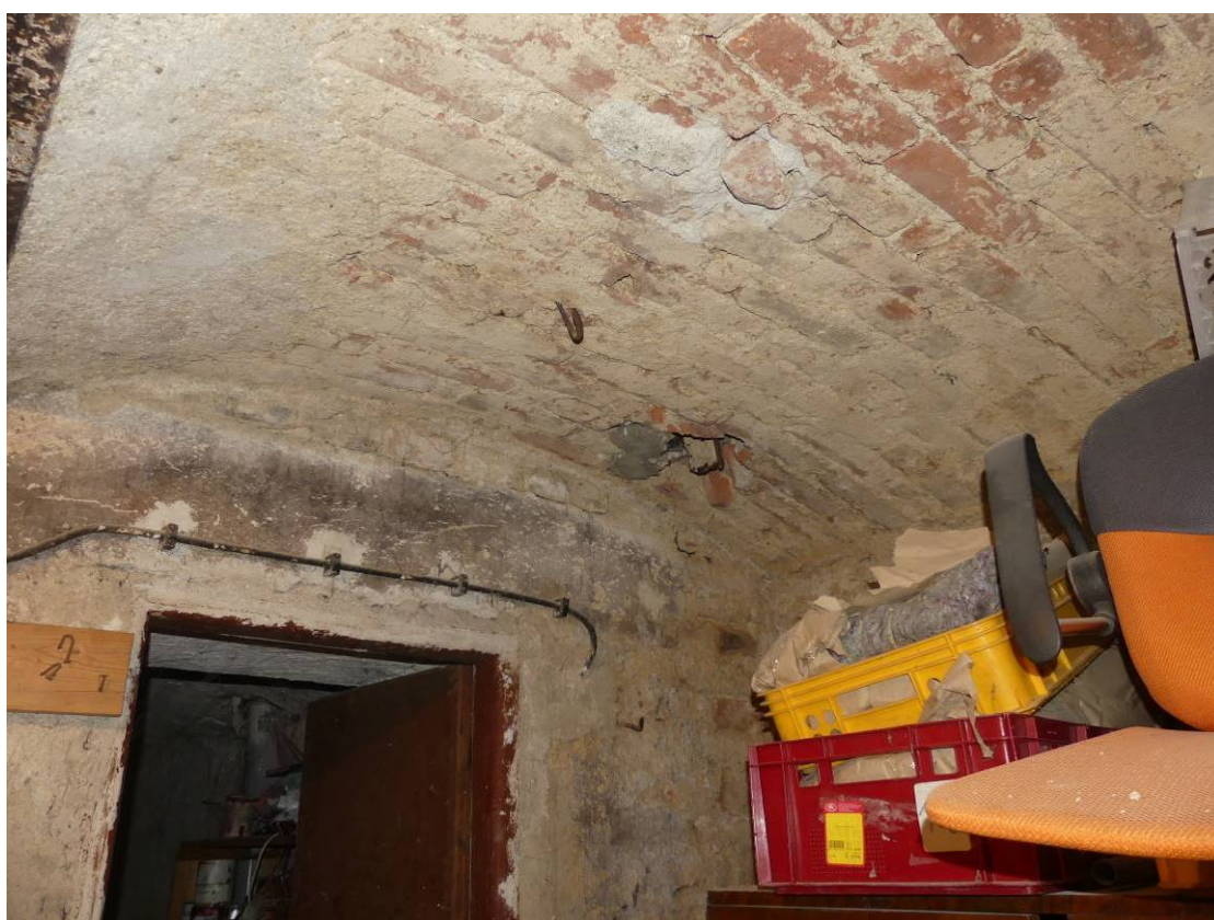
Foto 1.16 – Absence povrchových úprav a omítek v prostorách 1PP.
