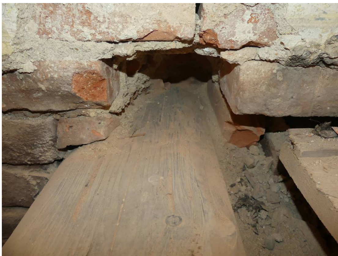
Foto 1.12 – Pohled na uloženou část stropního trámu, kdy zvýšená vlhkost způsobila degradaci dřevní hmoty po celé délce uložení trámu.
