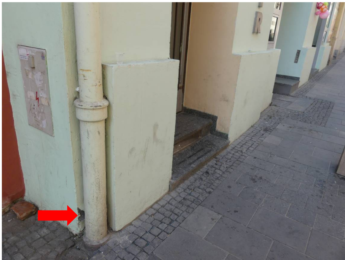
Foto 1.1 – Pohled na fasádu objektu, v místě u svodu dešťové vody lze vidět odpadlou omítku.
