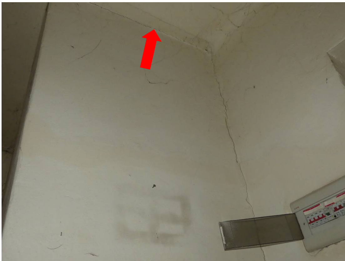
Foto 1.13 – Pohled na trhlinu ve stropu v místě napojení stěna – strop.
