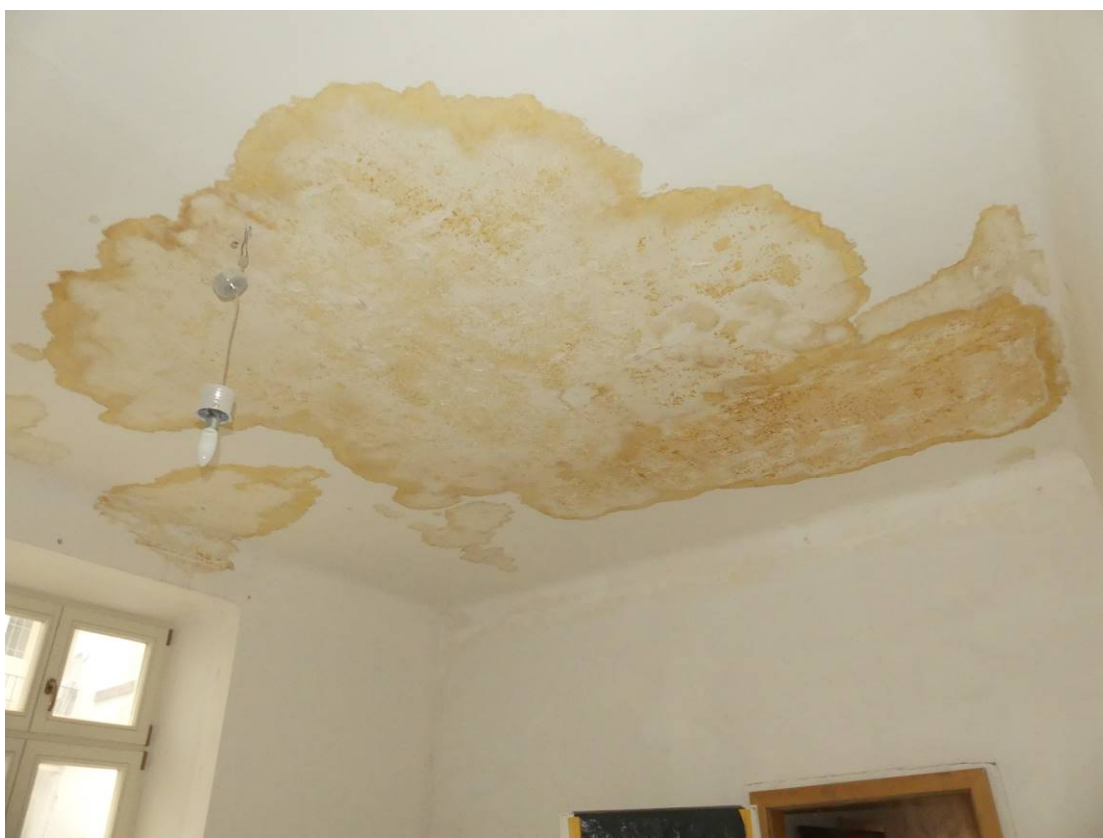
Foto 1.14 – Pohled na mapu po zatečení na stropu ve 3NP.
