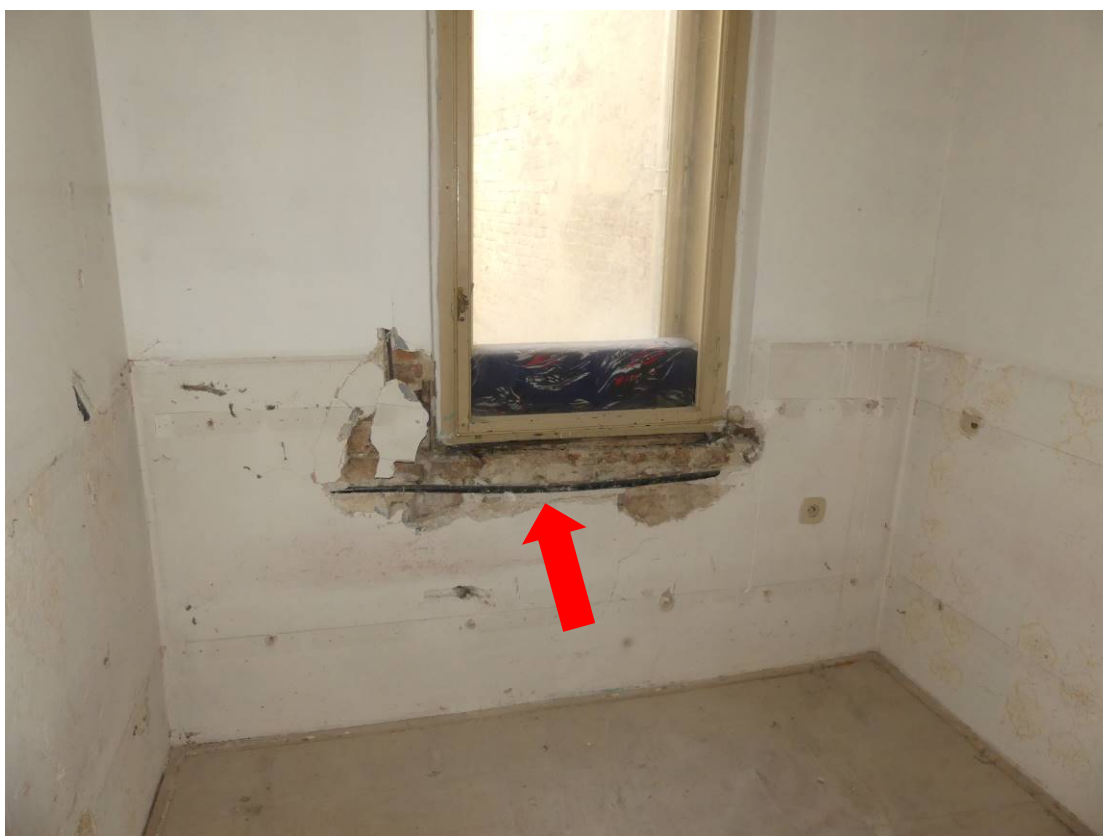
Foto 1.8 – Pohled na odpadlou omítku a chybějící parapet okenního otvoru.
