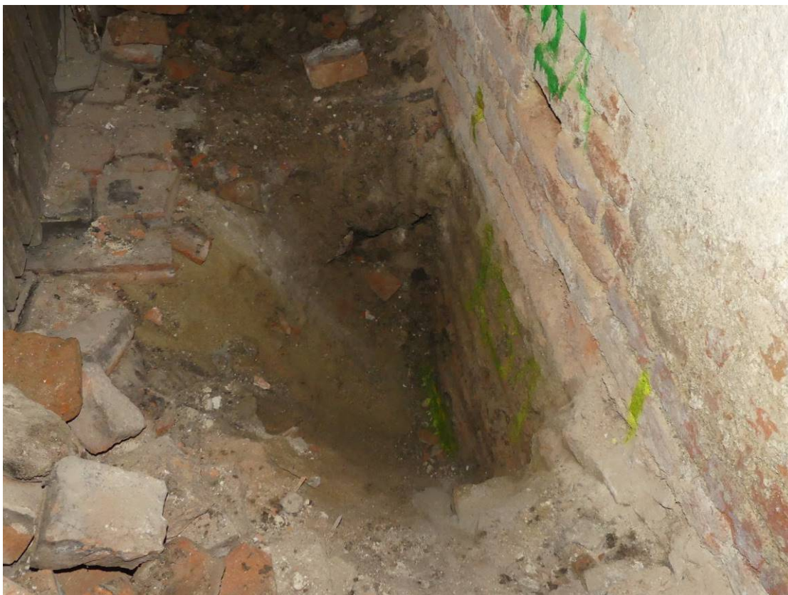
Foto 1.17 – Absence vodorovné hydroizolace v úrovni podlahy 1PP.
