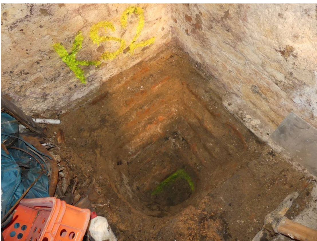
Foto 1.18 – Absence vodorovné hydroizolace v úrovni podlahy 1PP.
