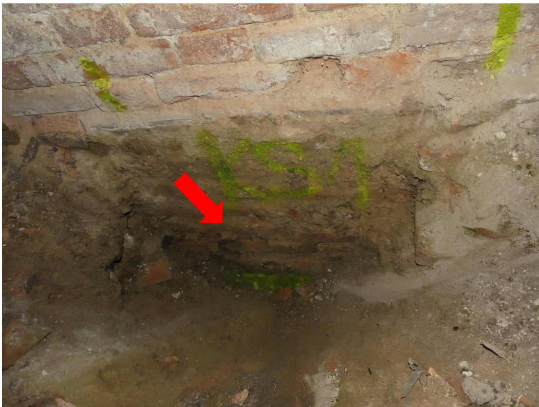
Foto 1.5 – Absence svislé hydroizolace v úrovni terénu v 1PP.
