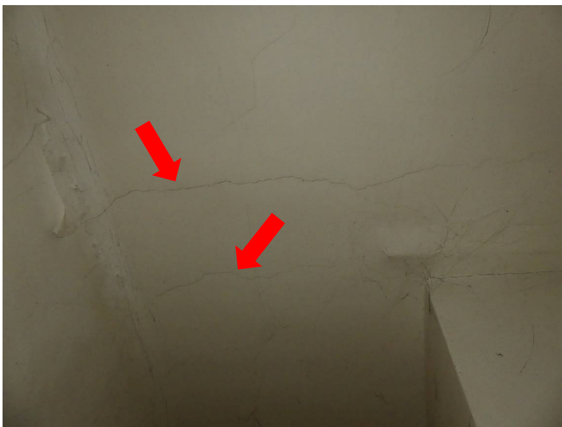
Foto 1.10 – Pohled na trhliny vyskytující se lokálně na stropě v celém objektu, trhliny dosahují šířky až 3,0 mm.
