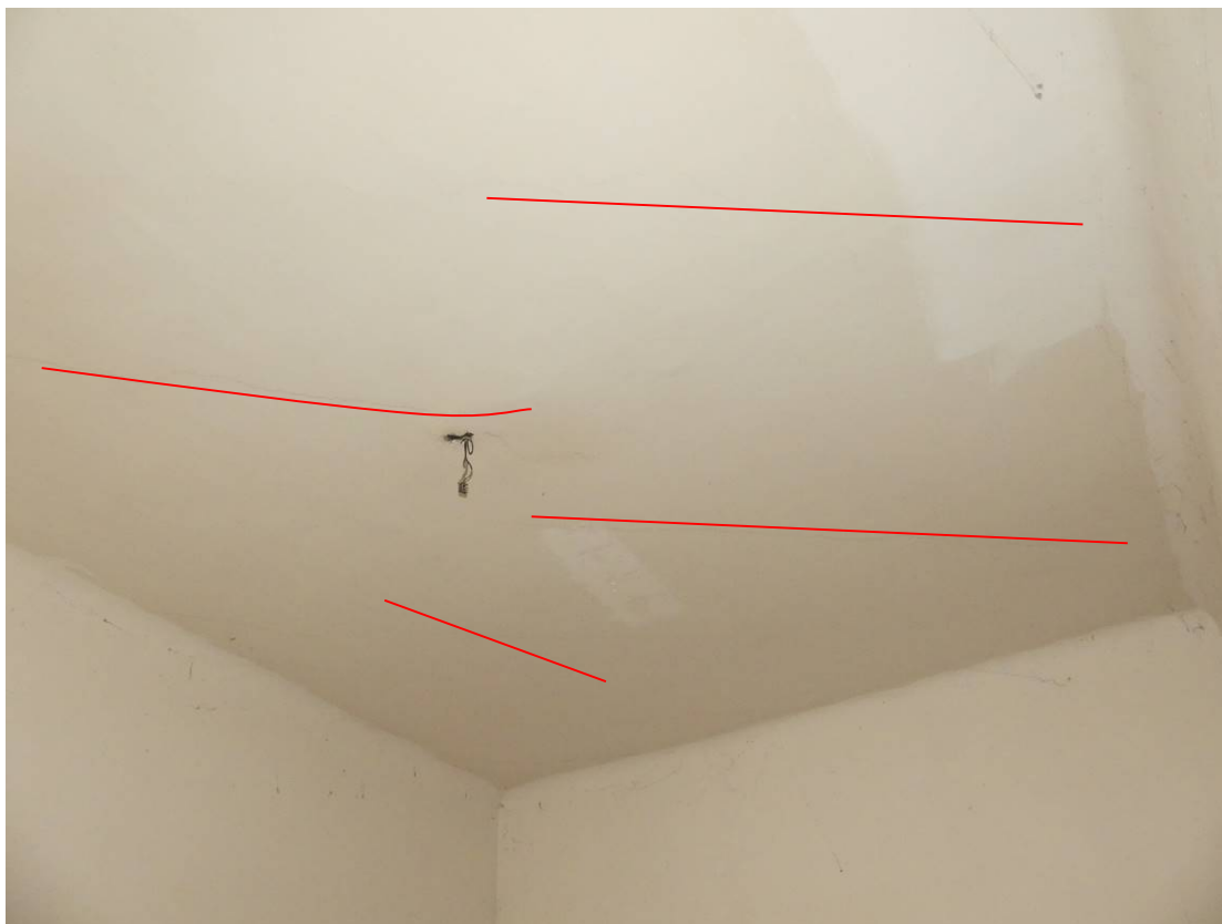
Foto 1.11 – Pohled na trhliny stropu v místnosti č. 3.003.03 ve 3NP.
