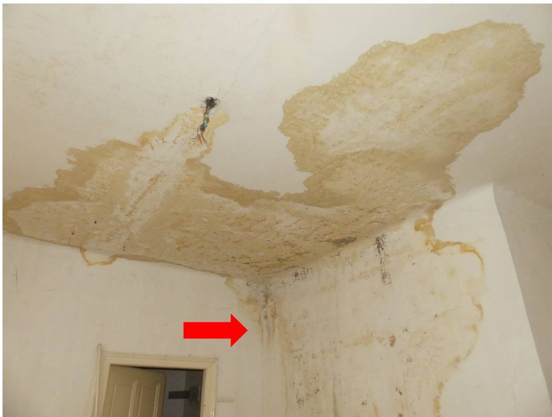
Foto 1.3 – Pohled na vlhkostní mapu na stěně a stropu v místnosti č. 3.003.07 ve 3NP.
