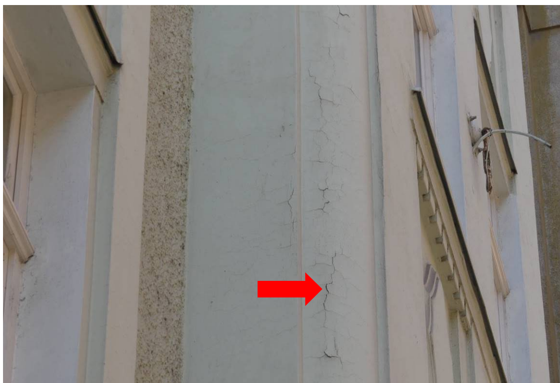
Foto 1.2 – Lokálně se na fasádě objektu objevují trhliny v omítkce.
