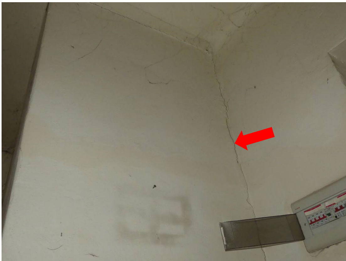
Foto 1.7 – Pohled na trhlinu v rohu stěn v místnosti č. 3.003.01 ve 3NP.
