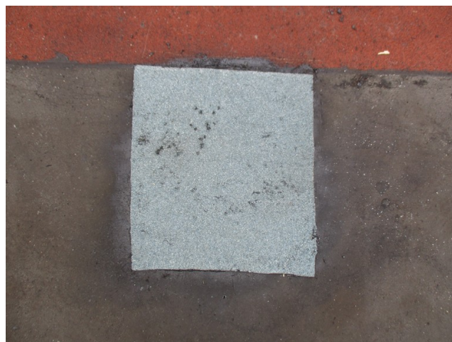
foto/4/ Pohled na zapravenou sondu S2
