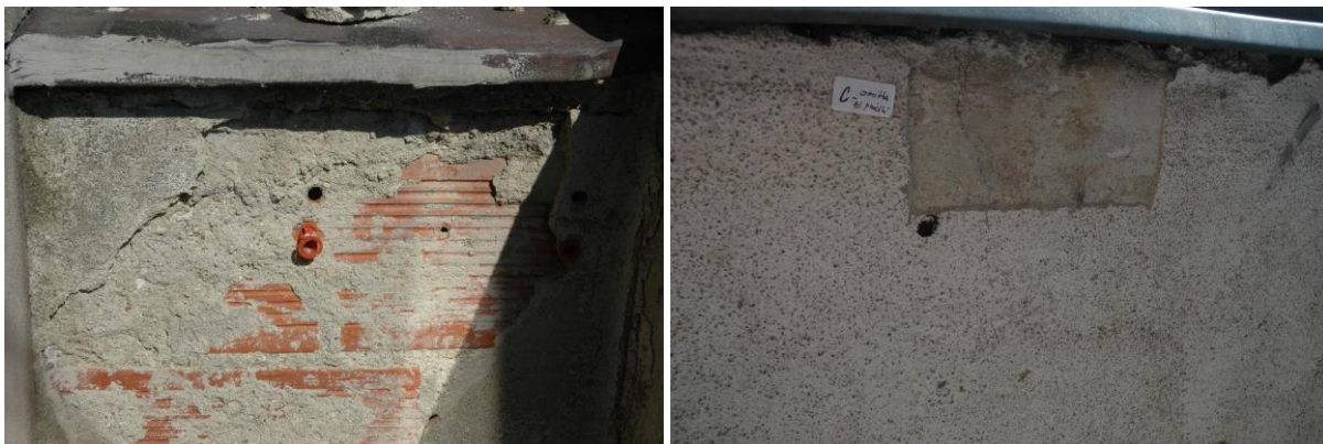
Na fotografii vpravo je místo odběru vzorku C, který byl předmětem materiálové analýzy (viz samostatná příloha. Petrografická a rtg-difrakční analýza, Mgr. D. Všíanský).
