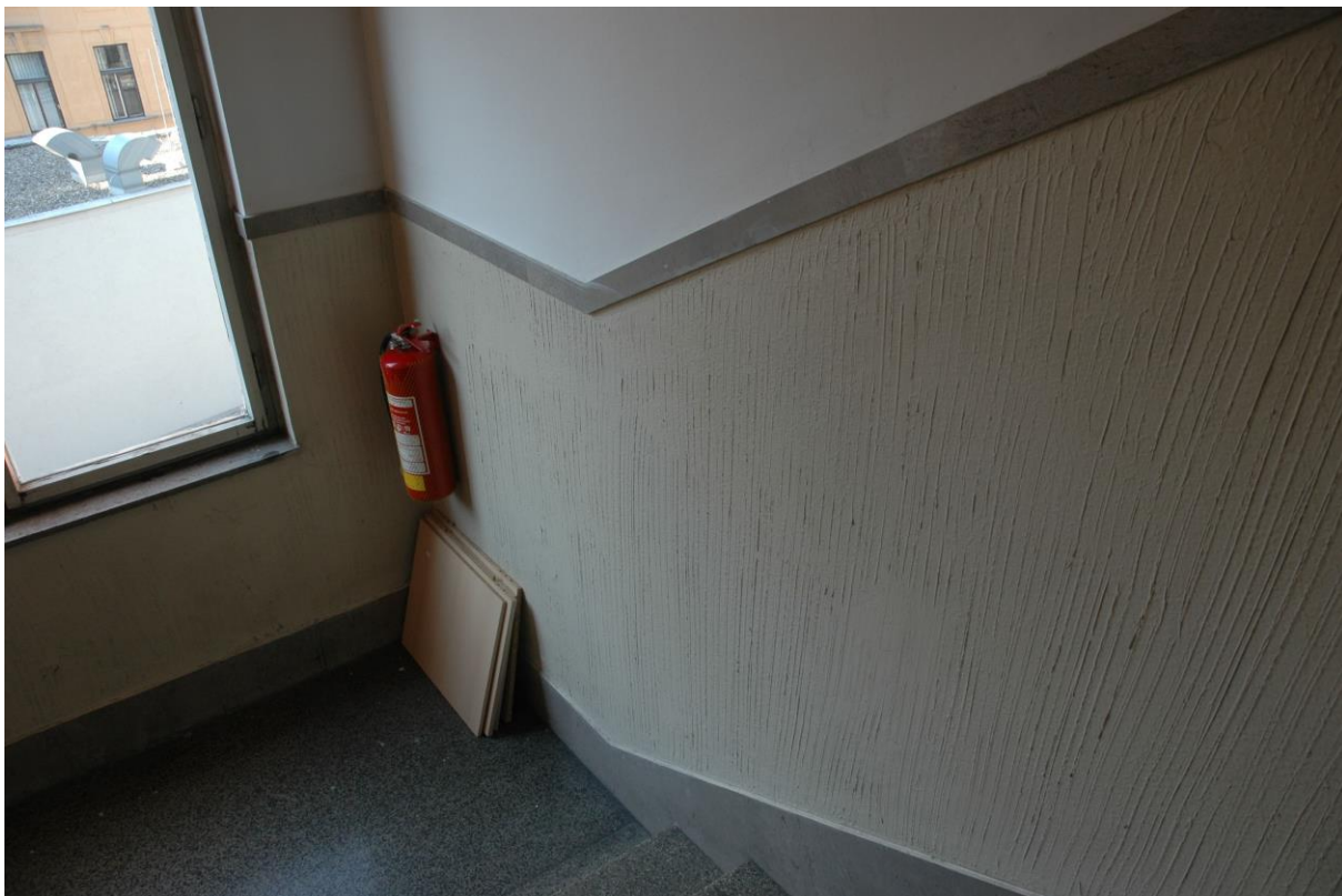
Celkový pohled – druhotná úprava ploch stěn schodiště pomocí „otěru vzdorných“ strukturovaných olejových nátěrů
