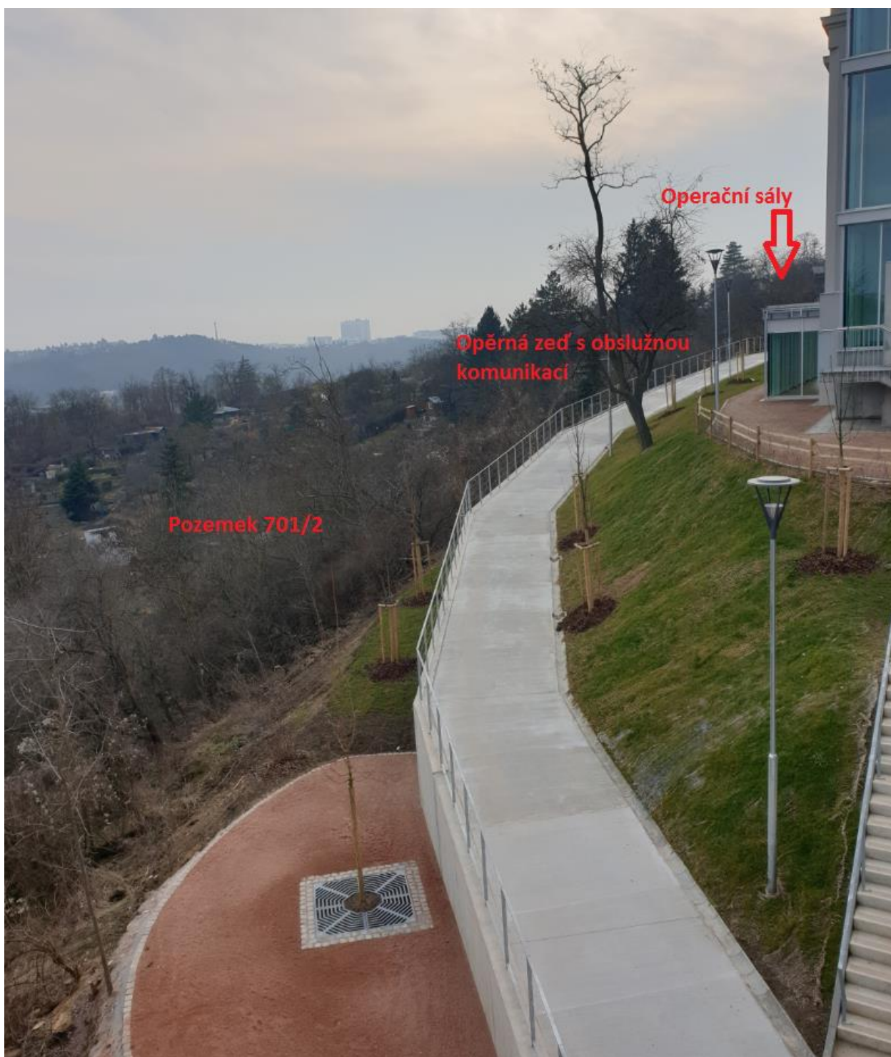
Obrázek č. 1. Opěrná zeď pod Bakešovým pavilonem s obslužnou komunikací pro operační sály
